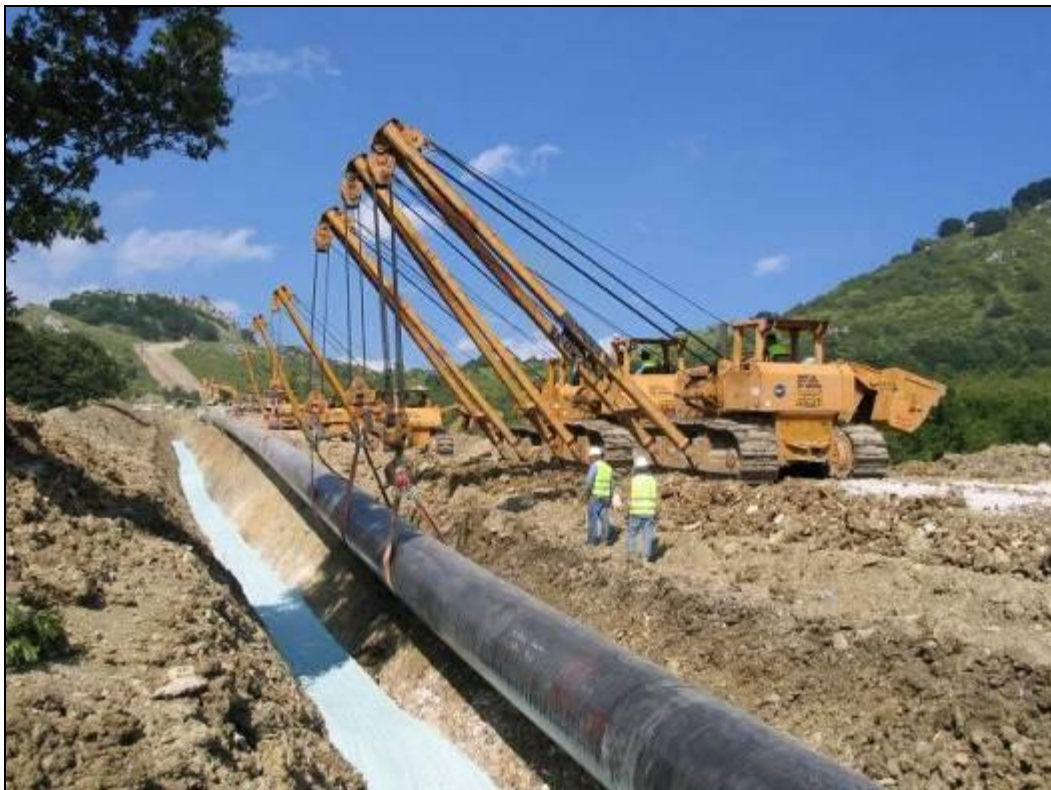
Fig. 5.1.9: Posa della condotta
