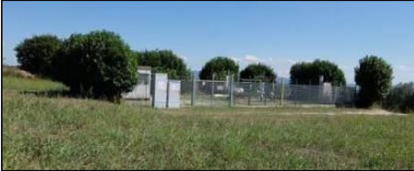
Foto 2/B– Impianto di partenza lungo il metanodotto All. Cellerio-Montalto di Castro
