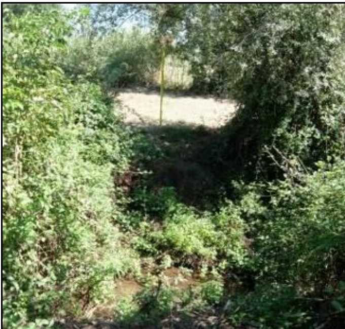
Foto 2/C – Attraversamento F.so Catenaccio
