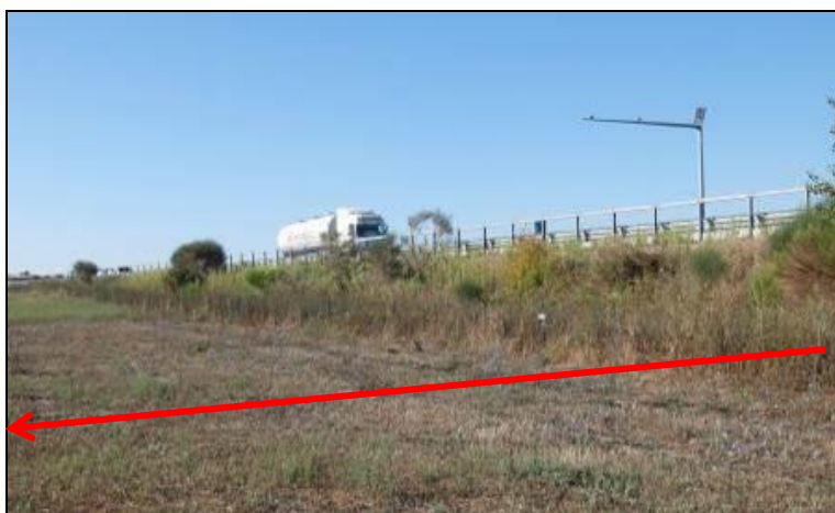
Foto 2/S– Punto di uscita dell'attraversamento della S.S. n° 675
