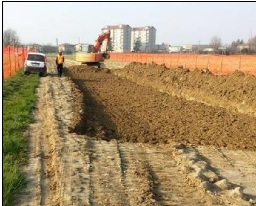
Fig. 5.1.2: Apertura della pista di lavoro
