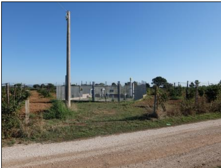
Foto 2/V – Impianto terminale n° 4104239/5.1
