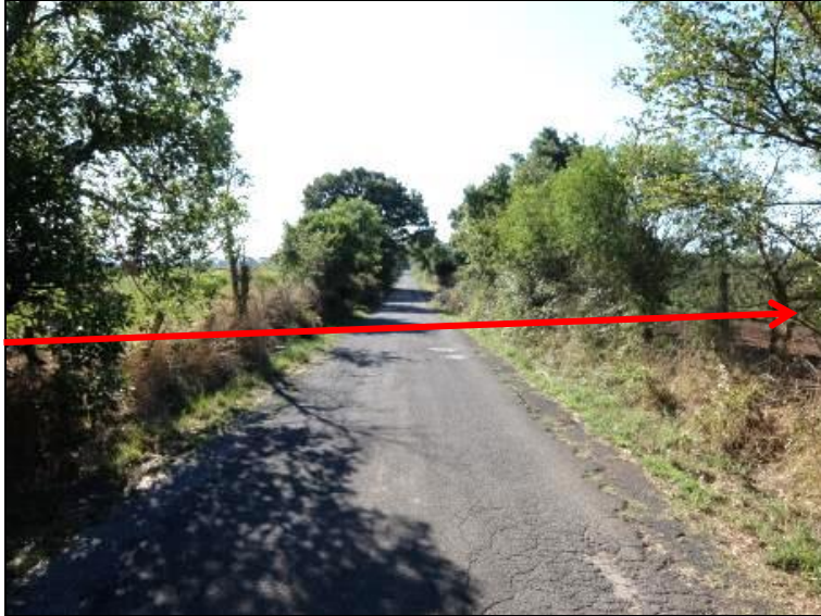
Foto 2/U – Attraversamento della S.P Nocchia
