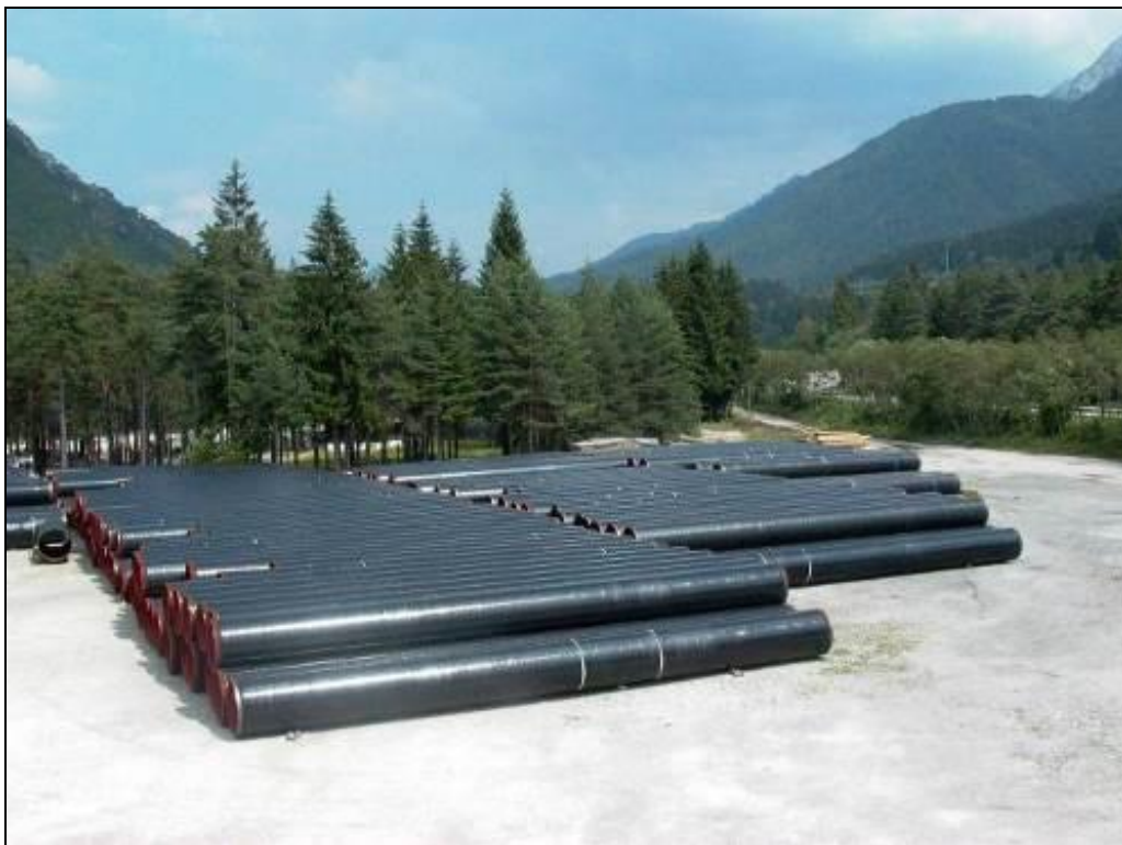
Fig. 5.1.1: Piazzola di accatastamento tubazioni
