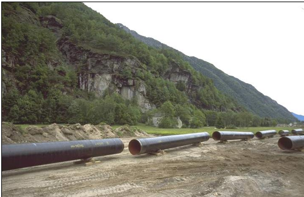
Fig. 5.1.4: Sfilamento tubi
