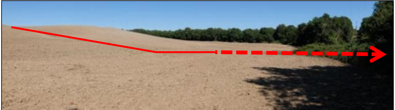
Foto 2/F – Discesa verso F.so Burleo, attraversato insieme con la S.P. 2 tramite T.O.C.
