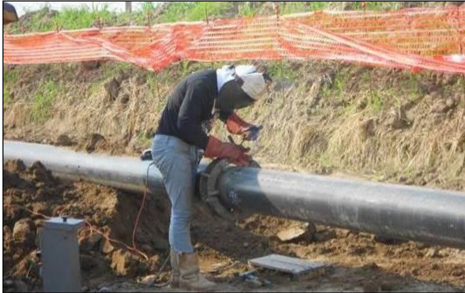
Fig. 5.1.5: Saldatura della tubazione
