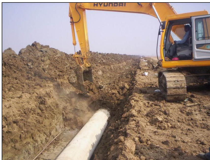
Fig. 5.1.10: Rinterro della condotta
