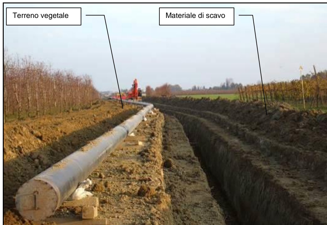
Fig. 5.1.7: Scavo della trincea
