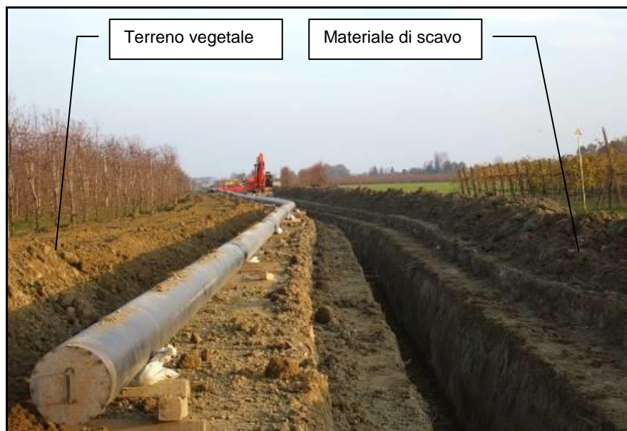
Fig. 2.3/D: Scavo della trincea
