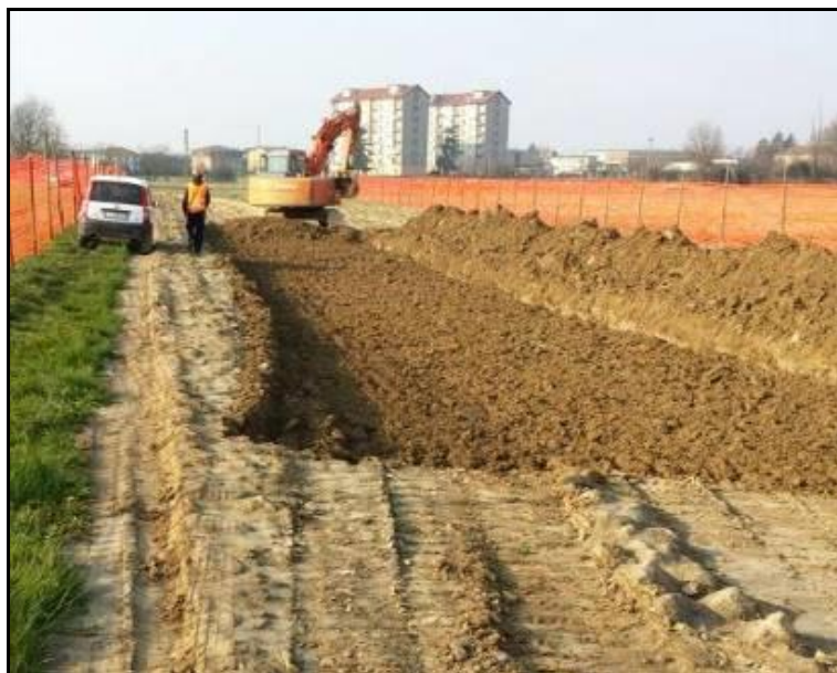
Fig. 2.3/B: Apertura della pista di lavoro
