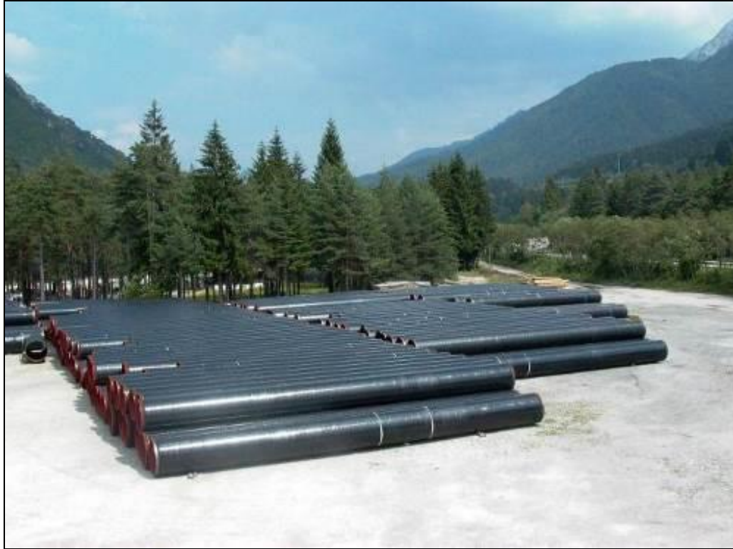
Fig. 2.3/A: Piazzola di accatastamento tubazioni
