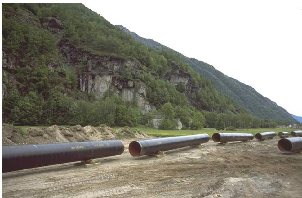
Fig. 2.3/C: Sfilamento tubi
