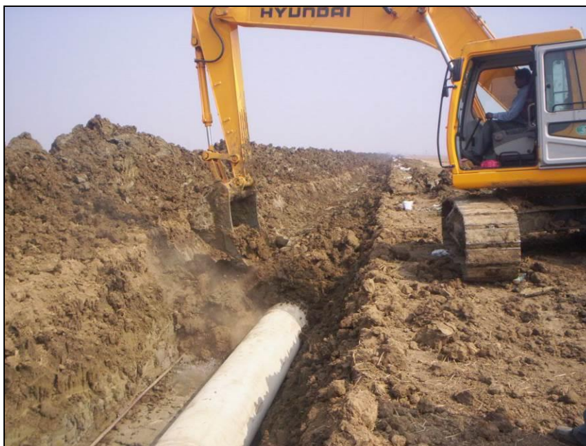
Fig. 2.3/E: Rinterro della condotta
