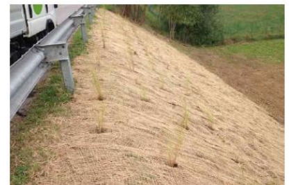
TRATTAMENTO ANTIEROSIVO DELLE SCARPATE IN RILEVATO REALIZZATO CON:
