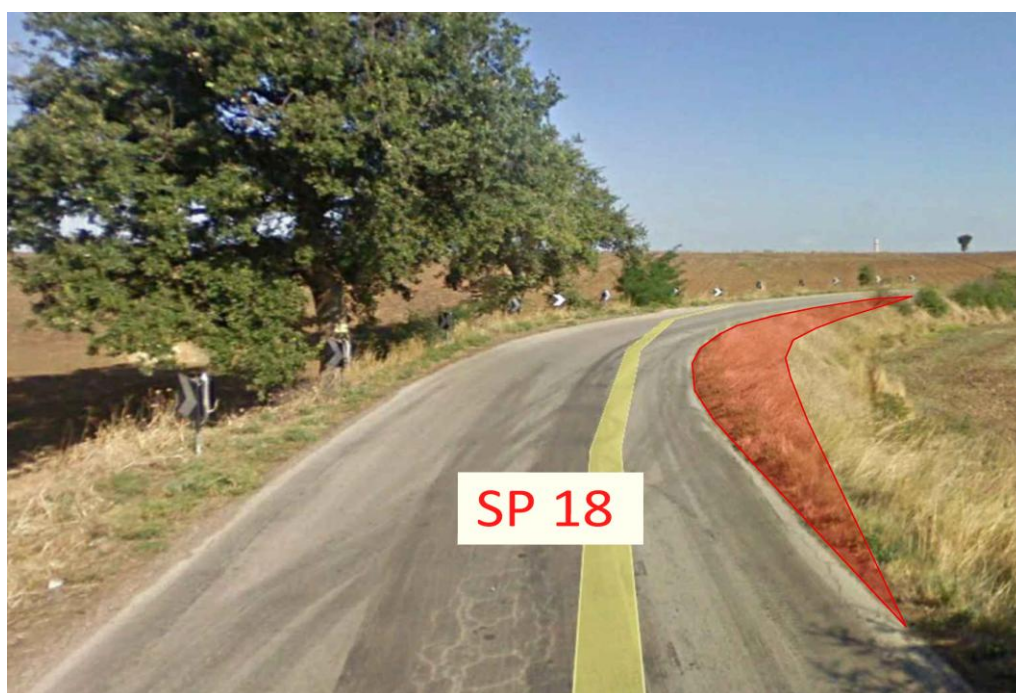
Figura 12 – Allargamenti in curva della carreggiata stradale
