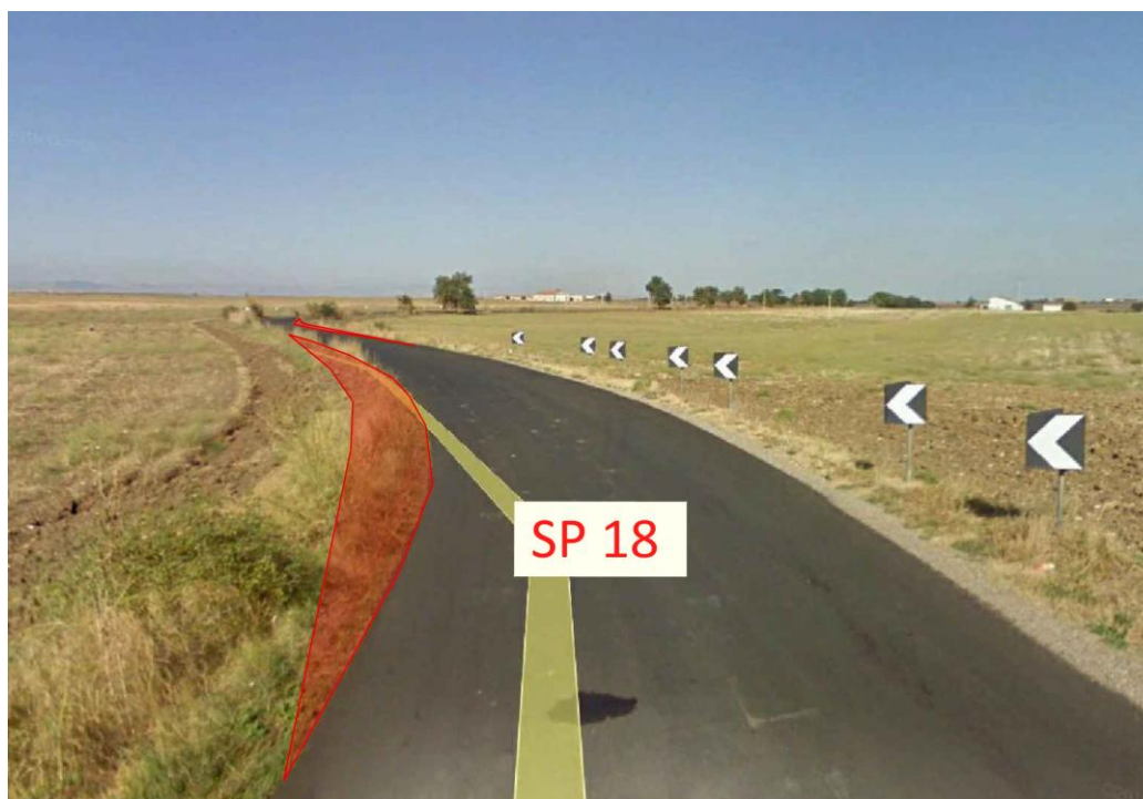
Figura 10 – Allargamenti in curva della carreggiata stradale
