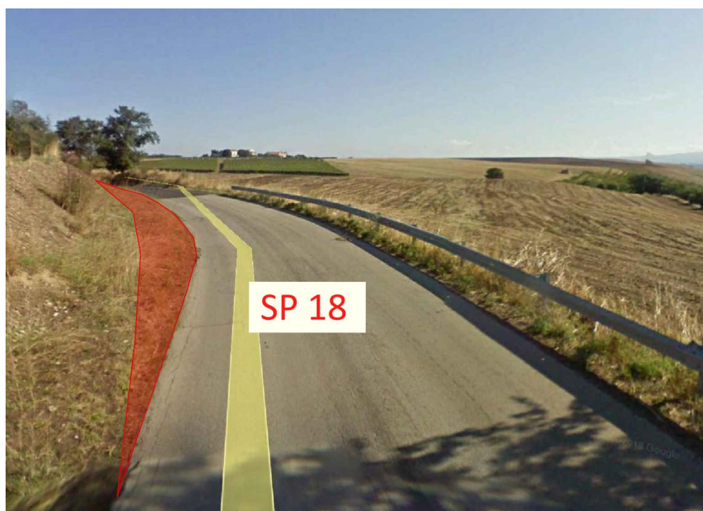
Figura 14 – Allargamenti in curva della carreggiata stradale
