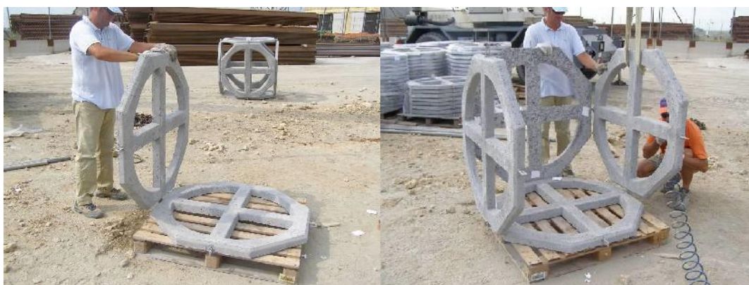
Fase di montaggio
