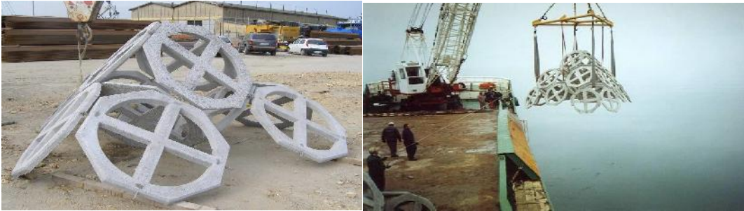
Sollevamento dei moduli
