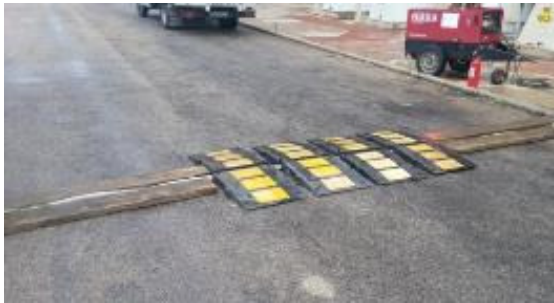
FIGURA 2 - PROTEZIONE CAVI ELETTRICI NEGLI ATTRAVERSAMENTI STRADALI
