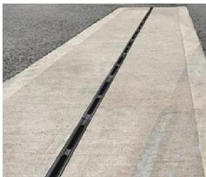
Figura 46 : Esempio di drenaggio della pista: a sinistra il canale a fessura. A destra una sezione trasversale tipologica del canale (Immagini tratte dal sito ACO.co.za) .
