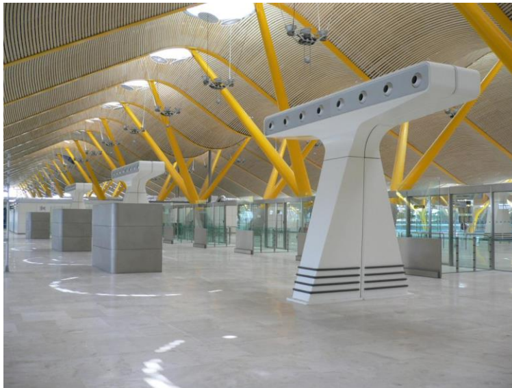
Figura 56 Diffusori per sistemi VAV
