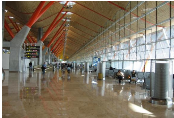
Figura 55: Diffusori per sistemi a dislocamento
