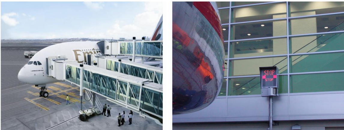
Figura 59: Pontili fissi e mobili dei passeggeri e sistema Visual Docking System
