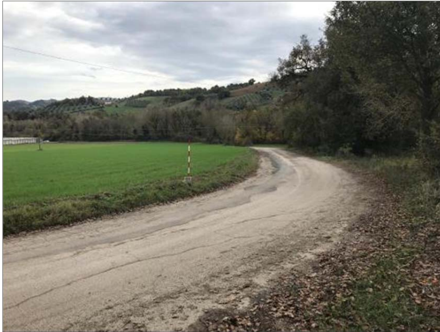
Foto 104. L'area del Cavidotto vista da Sud-Est.
