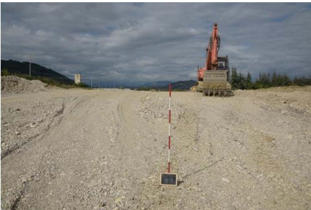
Foto 10. L'area del Sostegno B3 vista da Est.
