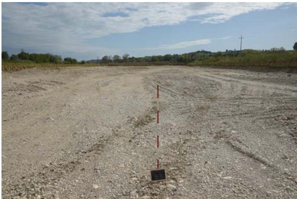
Foto 12. L'area del Sostegno B3 vista da Ovest.
