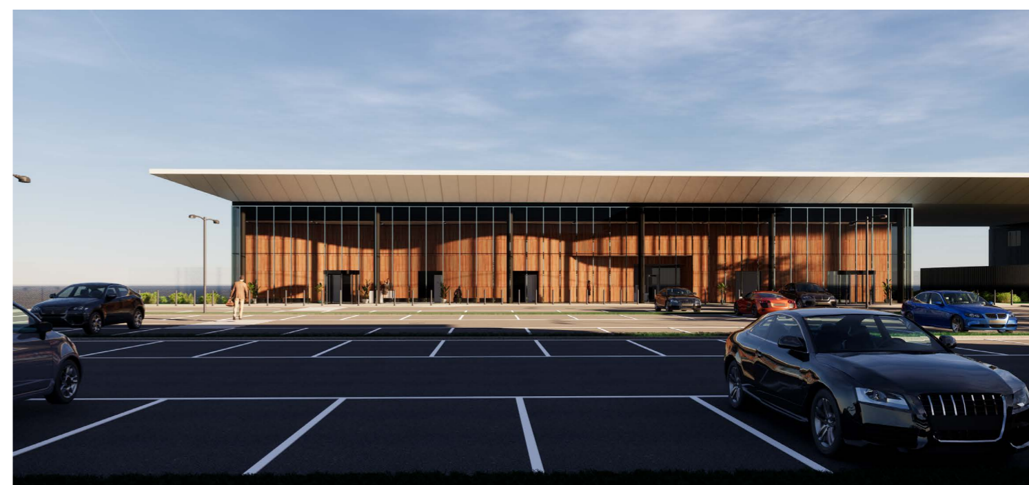
Viste del terminal di Aviazione Generale
