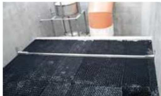
Layout con filtro orizzontale. Horizontal filters installation.
