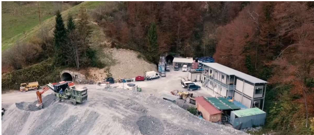
Figura 1.8: Panoramica dell'area di cantiere in località Cà Pasi. Sullo sfondo l'imbocco della galleria Forcella.
