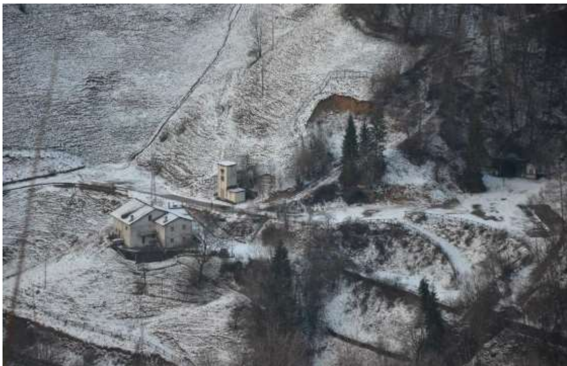
Figura 4.2: Panoramica del versante su cui insiste l'area di cantiere di Cà Pasi.
