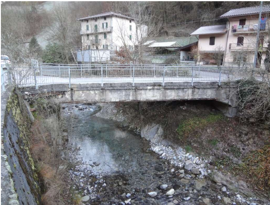
Figura 3.8: Ponte sul torrente Riso in corrispondenza della laveria. In sinistra idrografia da notare la presenza del substrato roccioso affiorante appartenente alla formazione di Gorno.
