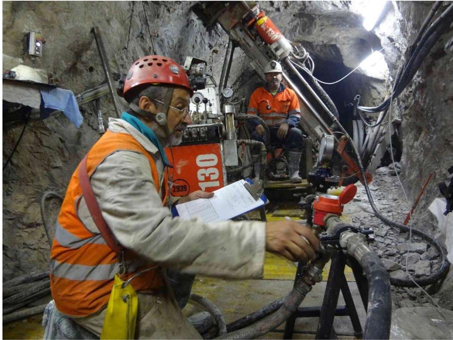
*Figura 4-14- Fasi esecutive delle prove Lugeon eseguite all'interno dei fori di sondaggio realizzati nel Ribasso Forcella.*
