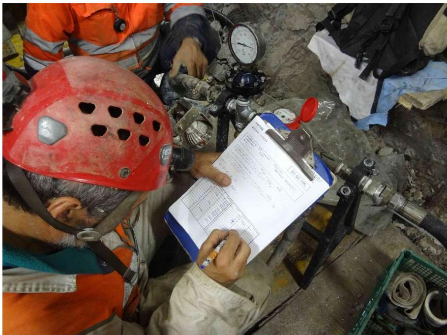
*Figura 4-15- Fasi esecutive delle prove Lugeon eseguite all'interno dei fori di sondaggio realizzati nel Ribasso Forcella.*
