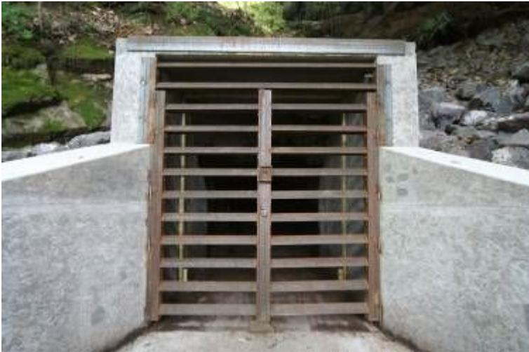
*Figura 409 – Esempio di griglia da posizionare all'ingresso delle gallerie.*
