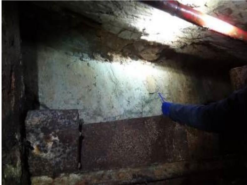
*Figura 245 - Piano di faglia della linea tettonica "Grem" che corre parallelamente all'asse della galleria Riso Parina tra pk 2000 e 4000 – Piedritto sinistro.*
