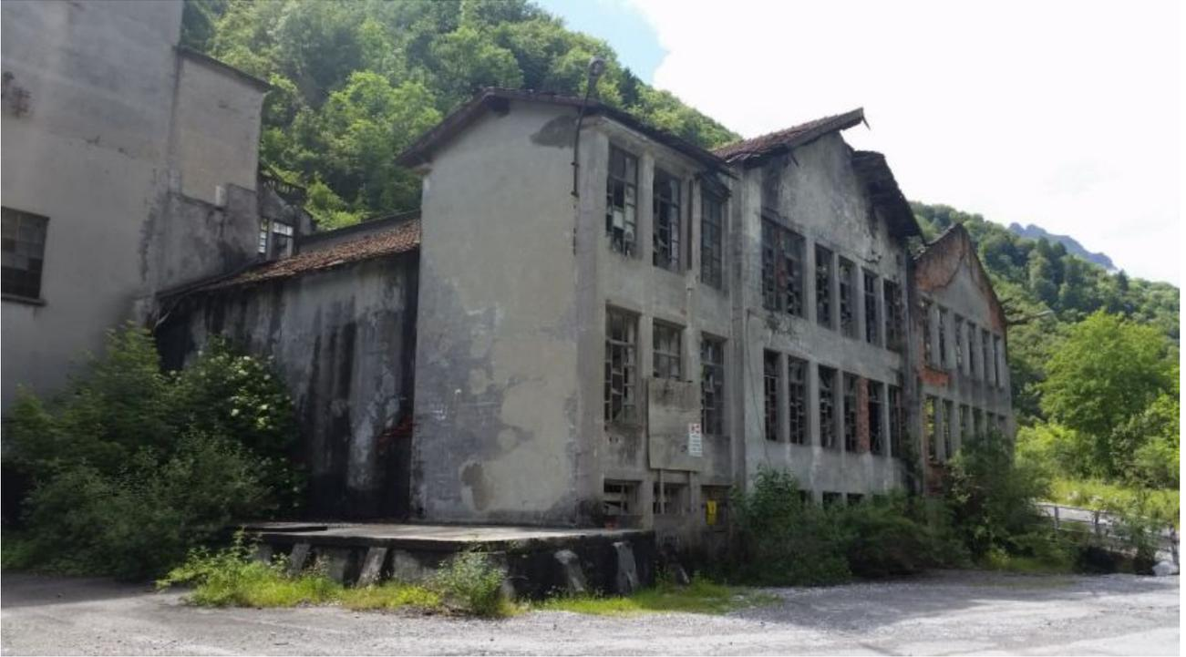
*Figura 10 - Avancorpo in fase di crollo posto in fregio al piazzale liberamente accessibile.*
