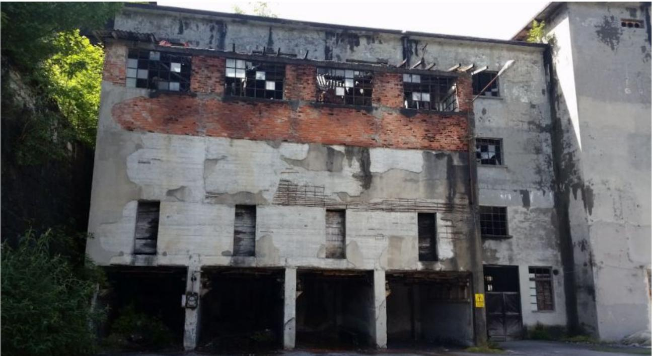
*Figura 11 - Tramogge laterali in c.a. e laterizio in avanzato stato di degrado.*
