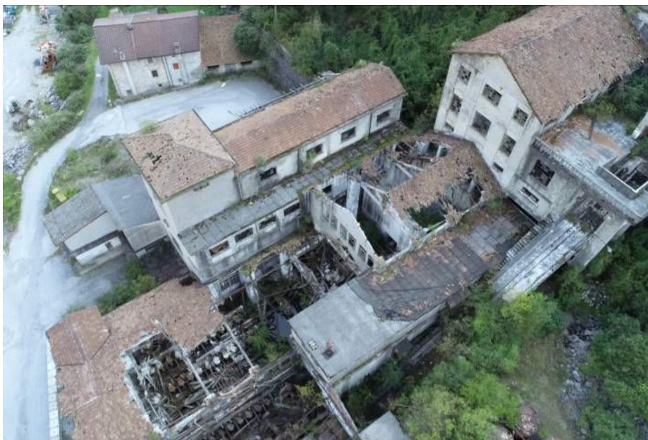
*Figura 13 - Vista dall'alto della laveria con evidenza del crollo delle coperture.*
