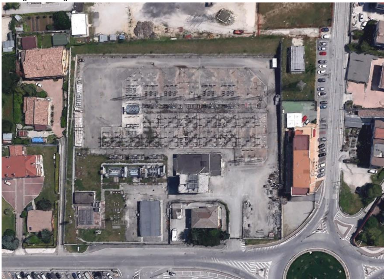
Ortofoto Stazione elettrica
