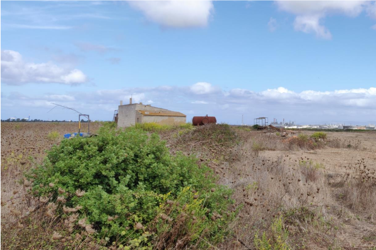
Figura 4: fabbricato nell'area di pericolosità del WTG01– Casolare
