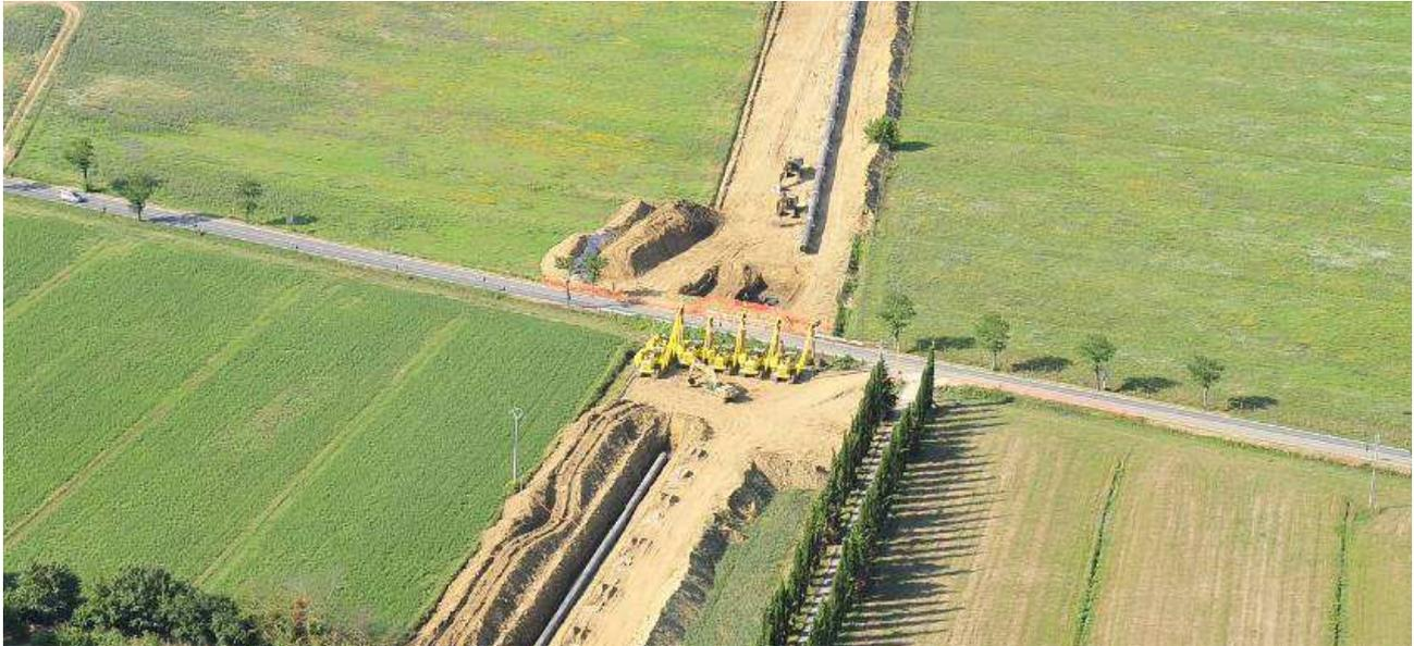
**Figura 7 – Panoramica dell'area di un tratto di metanodotto soggetto a TOC per l'attraversamento di un'infrastruttura viaria.**
