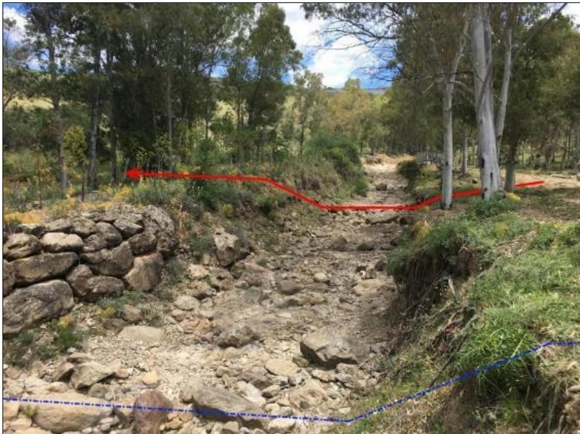
Figura 3.2: Foto ambito di attraversamento del corso d'acqua. Metodologia di attraversamento: scavo a cielo aperto.
