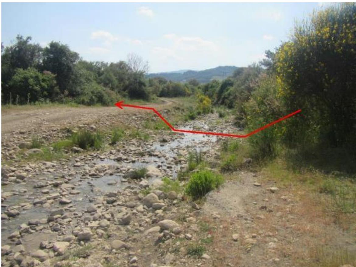
Figura 3.12: Foto ambito di attraversamento del corso d'acqua. Metodologia di attraversamento: scavo a cielo aperto.
