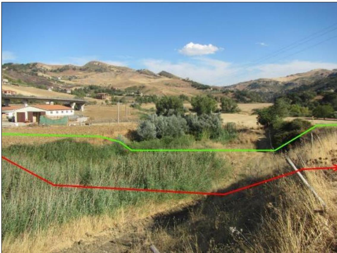
Figura 3.22: Foto ambito di attraversamento del corso d'acqua. Metodologia di attraversamento: scavo a cielo aperto.
