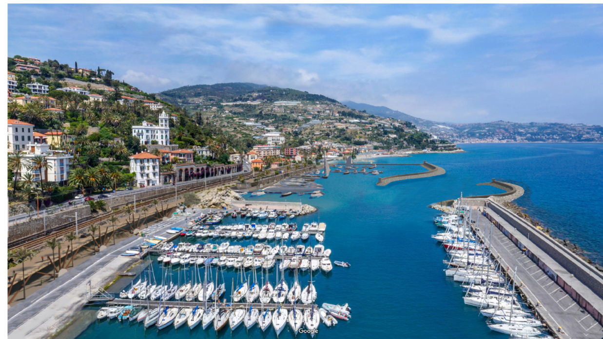
Ripresa drone in asse alla radice della diga esistente Nuova proposta 2019
