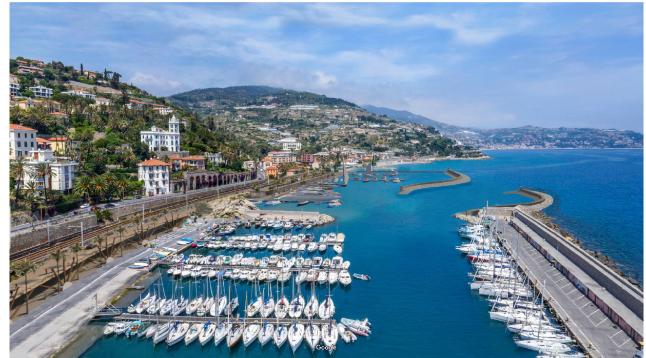
Ripresa drone in asse alla radice della diga esistente Nuova proposta 2019
