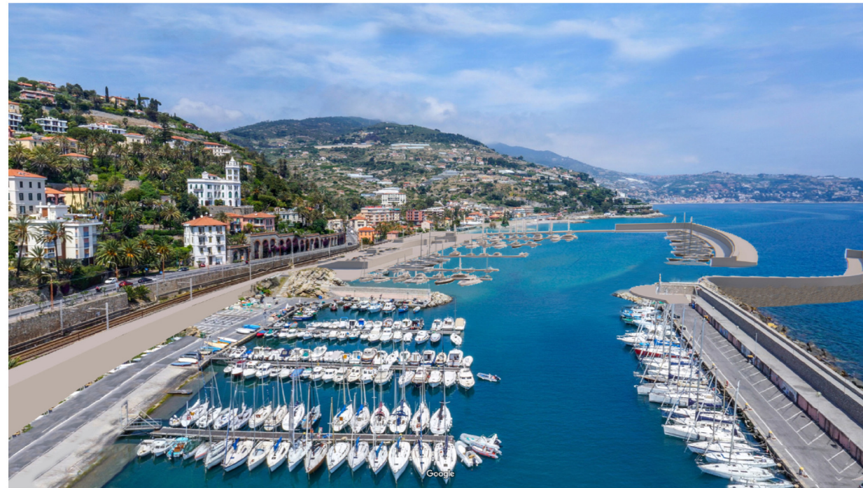
Ripresa drone in asse alla radice della diga esistente Progetto definitivo 2009
