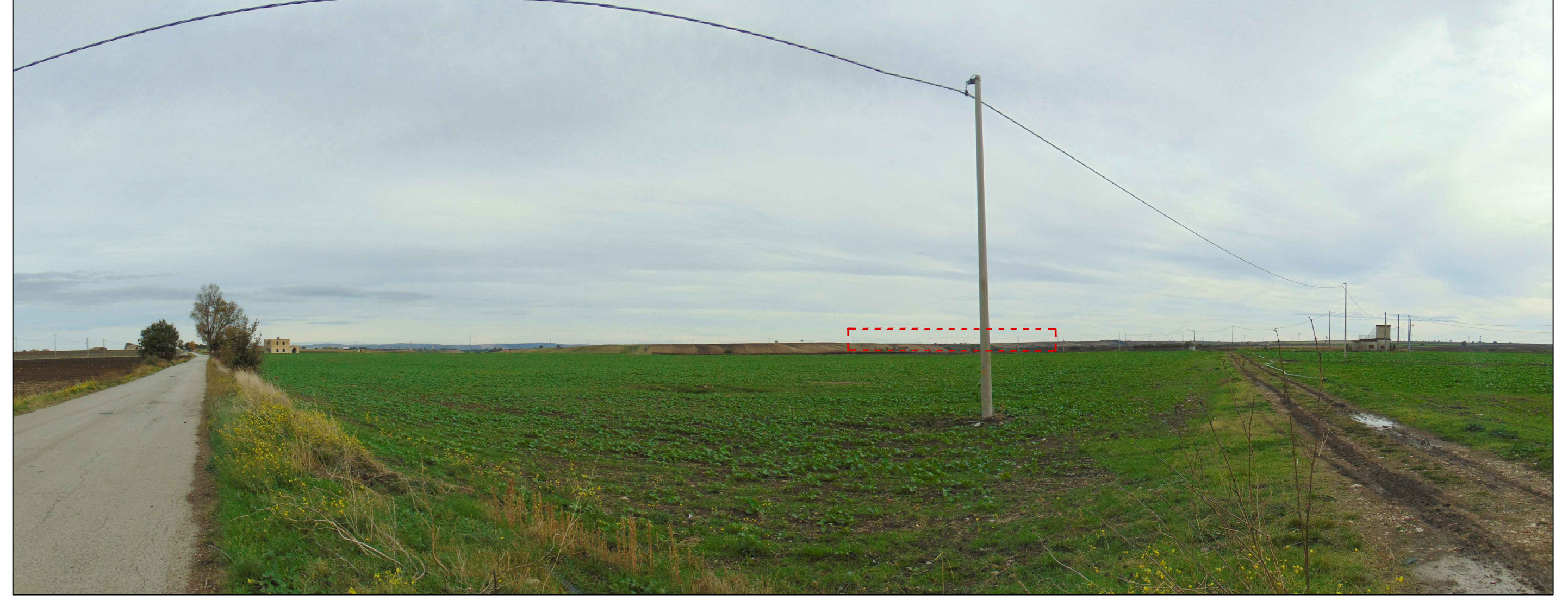
S5 Panoramica - Stato di Fatto
