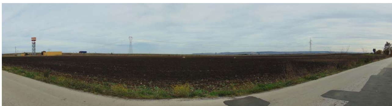
Figura 209 – Vista panoramica dell'area della stazione di trasformazione (rif. Cono2 di fig. 207)
