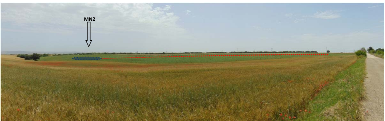
Figura 37 - Panoramica WTG MN2 - rif.cono 2 fig.25
