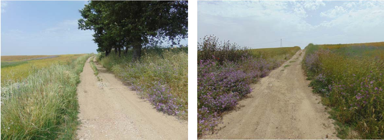
Figura 76 – Vista della strada esistente per l'accesso alla MN4 (rif. Cono4 fig. 72)
