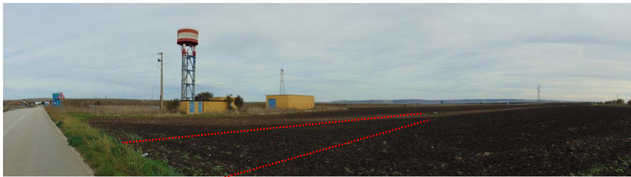
Figura 208 – Vista panoramica dell'area della stazione di trasformazione (rif. Cono1 di fig. 207)
