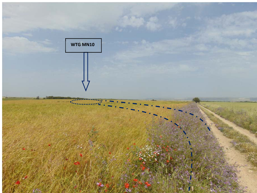
Figura 75 – Vista dell' accesso alla turbina MN10 (rif. Cono3 fig. 72)
