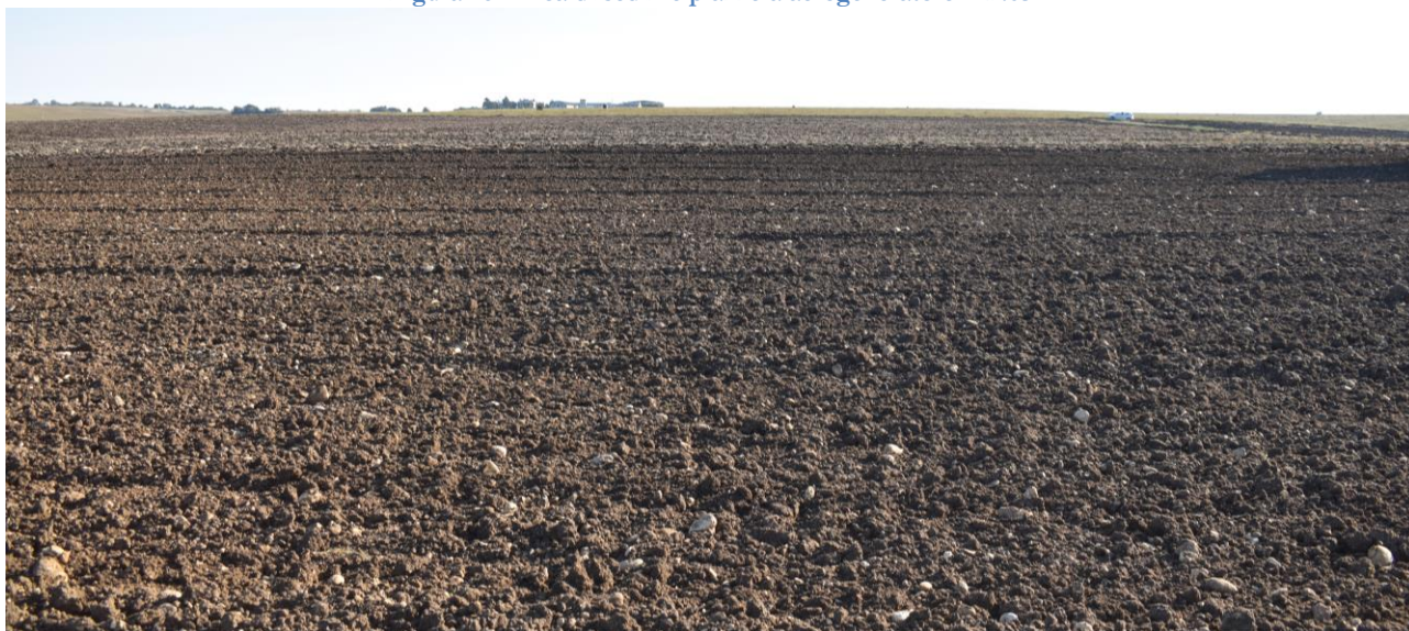
Figura 27 - Area di sedime della piazzola dell'aerogeneratore MN06
