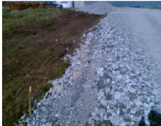
Figura 47: Superficie stradale in misto stabilizzato e drenaggio
