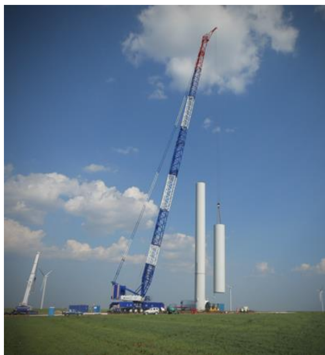
Figura 61 - Sollevamento, posizionamento e fissaggio dei tronconi intermedi
