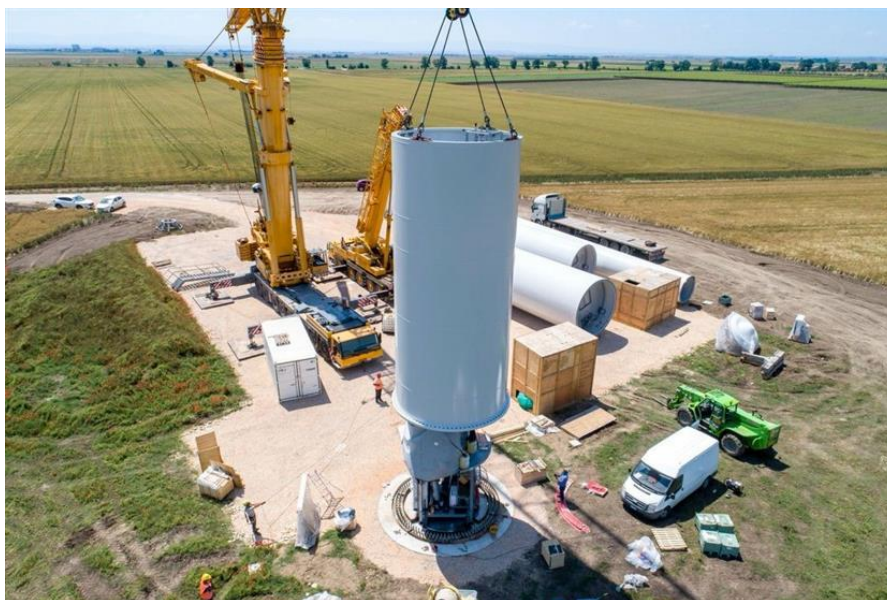
Figura 60 - Sollevamento e posizionamento alla fondazione della parte inferiore della torre
