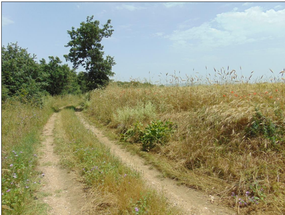
Figura 52 - Sentiero esistente da adeguare
