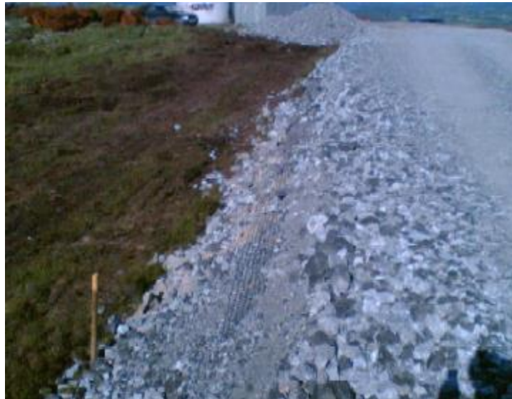
Figura 56: Superficie stradale in misto stabilizzato e drenaggio
