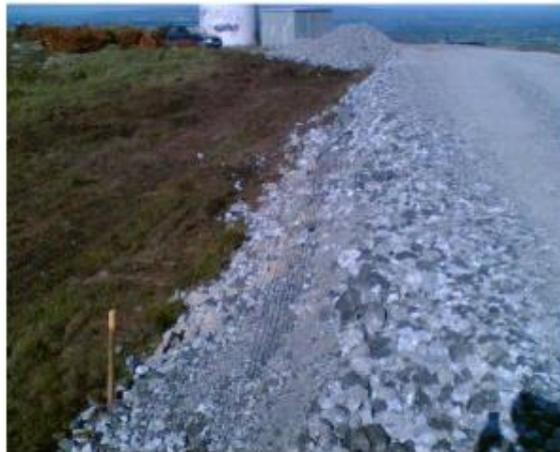
**Figura 8 - Tipologia di nuova viabilità in misto stabilizzato**
