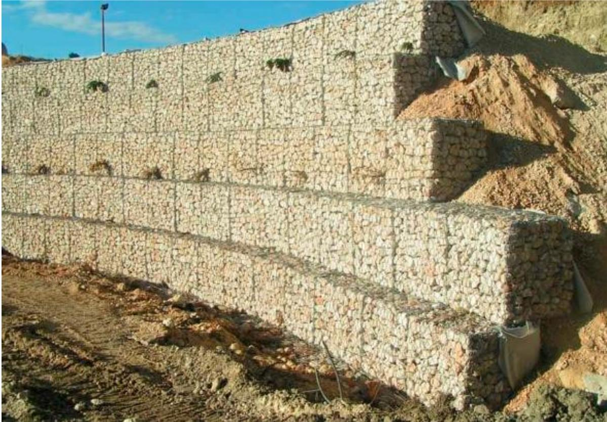
Figura 8 - Esempio di gabbionate rinverdite
