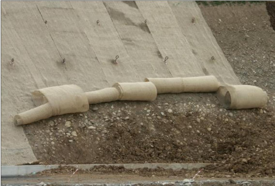
Figura 6 - Esempio di rivestimento in geotuoia
