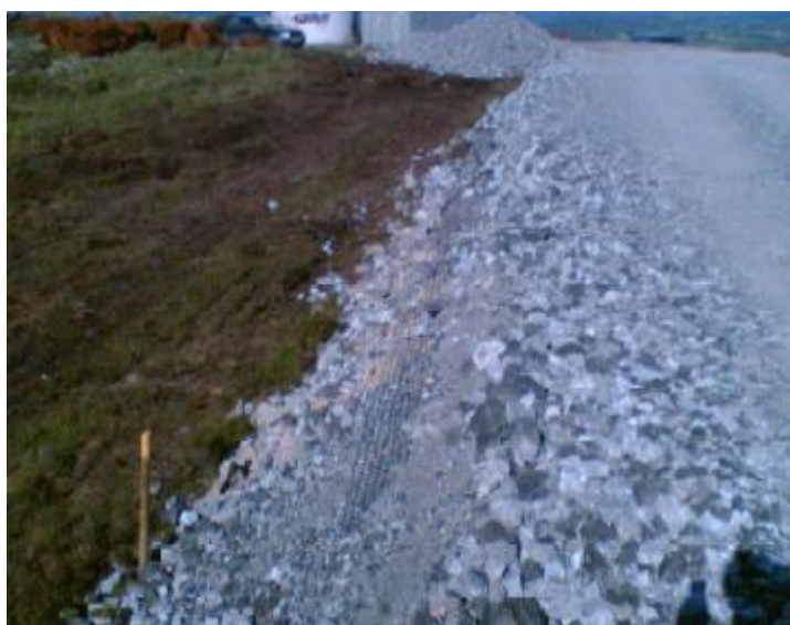
Figura 8: Superficie stradale in misto stabilizzato e drenaggio
