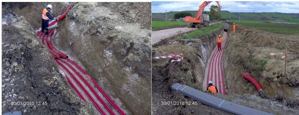
Figura 17: posa in opera dei cavi
