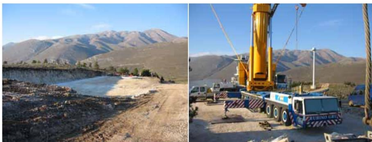
Figura 20: piazzole e gru per il montaggio pale
