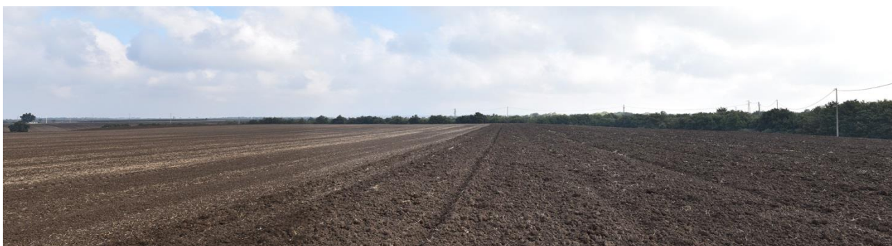
Figura 3 - Area di sedime piazzola aerogeneratore MN02
