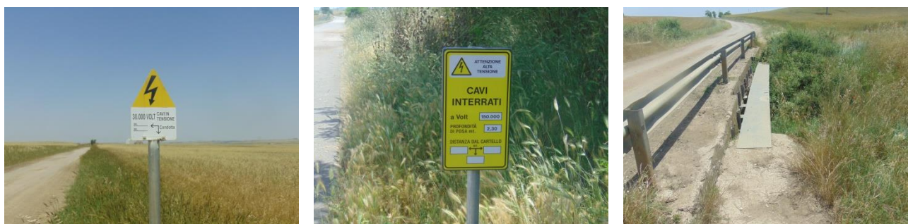
Figura 19. Segnalazioni cavi interrati lungo la SP 79
