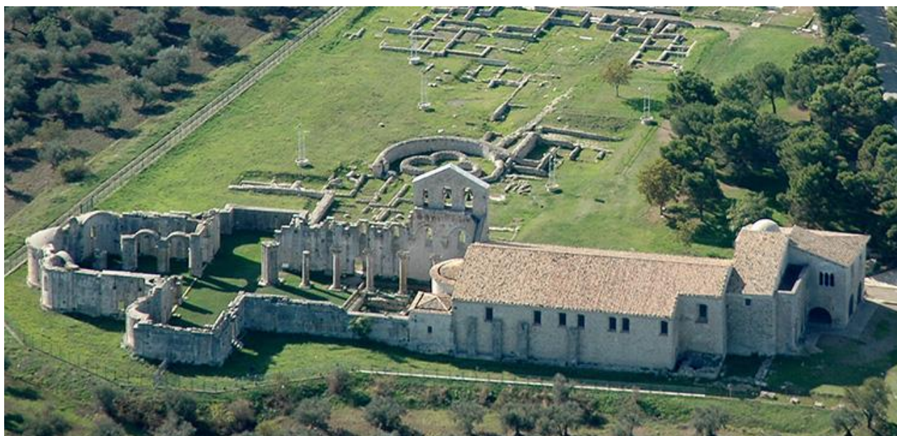
Figura 60: chiesa dell'incompiuta cono 10B
