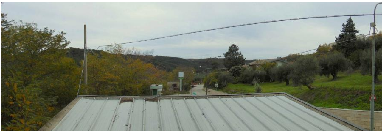
Figura 23: ripresa fotografica dei luoghi allo stato dell'arte
