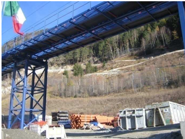
Baustelle Mauls / Cantiere di Mules
