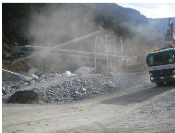
Polveri prodotte delle varie attività di cantiere
