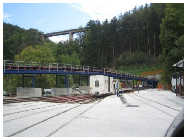
Förderband / Nastro trasportatore
