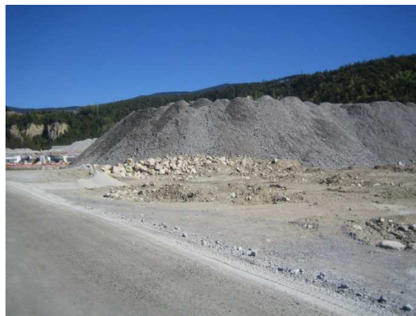
Aushubmaterial / Cumuli di materiale
