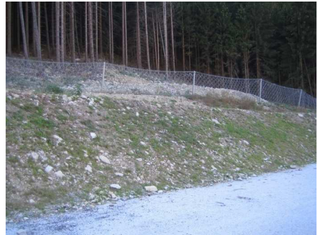
Reti paramassi a protezione della pista ciclabile
