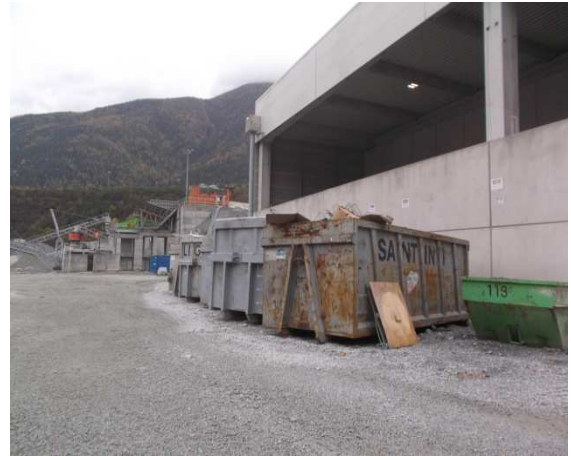
Baustelle Hinterrigger / Cantieri di Hinterrigger
