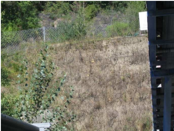
Barriere paramassi sopra il portale nord
