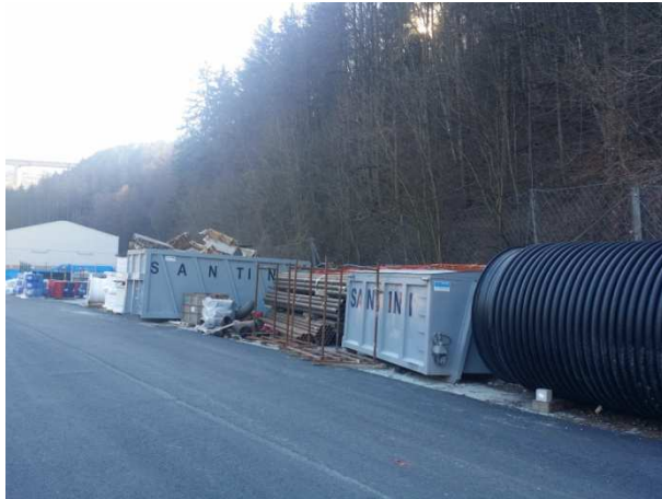
Baustelle Unterplattner/Cantieri di Unterplattner
