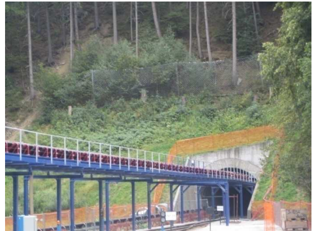
Barriere paramassi sopra il portale sud
