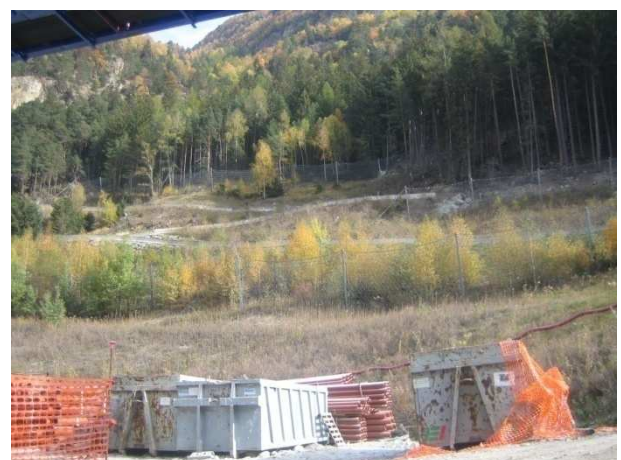
Steinschlagnetz oberhalb des Portals / Reti paramassi sopra il portale
