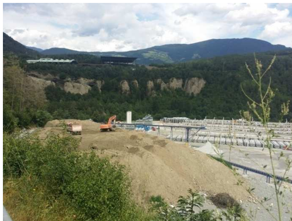
Bewegung von Humuserde auf dem neuen Standort auf der Baustelle Hinterrigger Movimentazione di terreno vegetale nella nuova collocazione presso l'area di Hinterrigger
