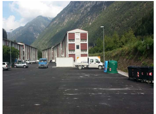
Basislager Franzenfeste / Campo base Fortezza
