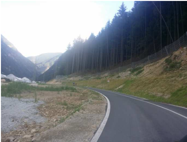
Reti paramassi a protezione della pista ciclabile
