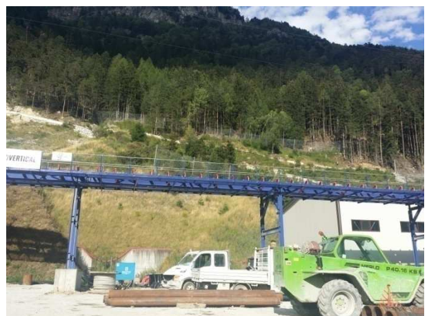
Rinverdimento versante sopra il cantiere
