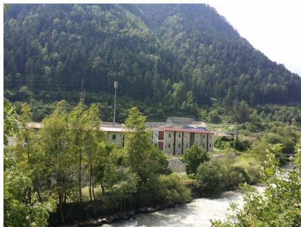
Ansicht der Baustelle von der Schnellstraße Vista area di cantiere dalla strada statale
