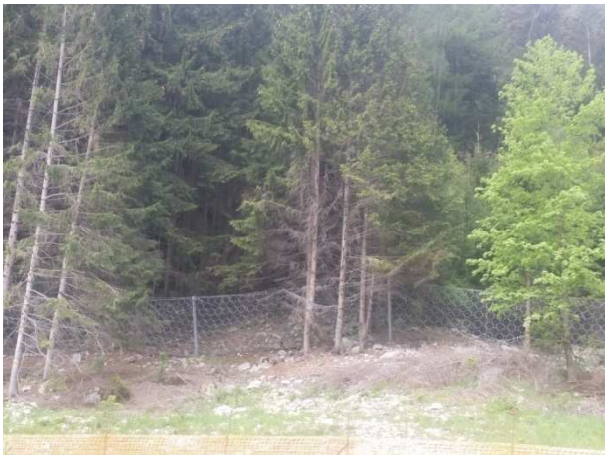
Steinschlagschutznetze oberhalb des Radweges - Reti paramassi a protezione della pista ciclabile
