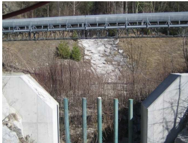
Geschieberückhaltesperre im östlichen Sektor der Baustelle - Briglia nell'area est del cantiere
