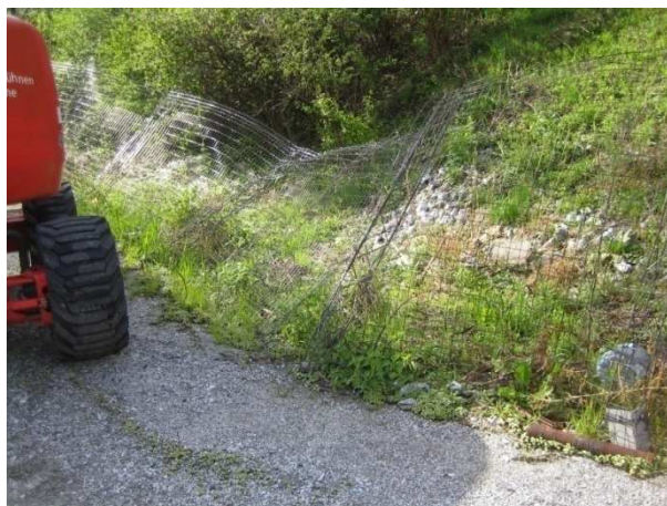
Baustellenabgrenzung - Rete di confine
