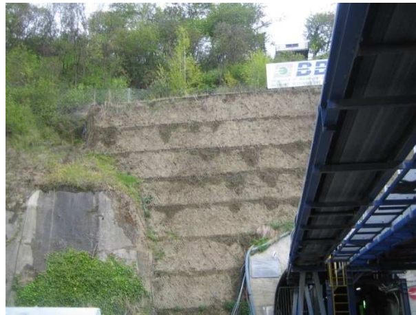
Portal Unterplattner, Tunnel Aicha - Muls Portale Unterplattner del cunicolo Aica-Mules
