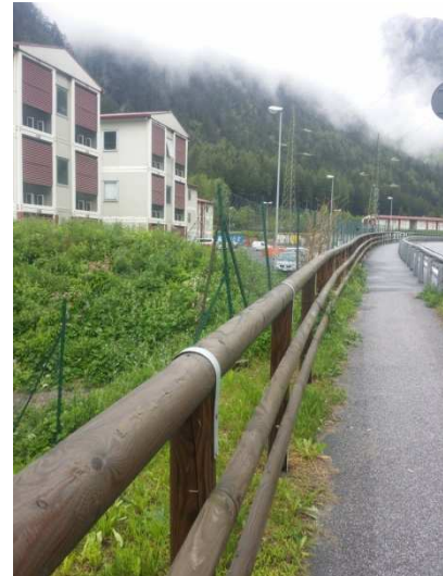
Ansicht der Baustelle von der Staatsstraße - Vista area di cantiere dalla strada statale
