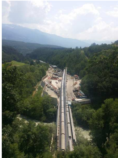
Ansicht von oben auf das Baustellengelände Vista dall'alto area di cantiere
