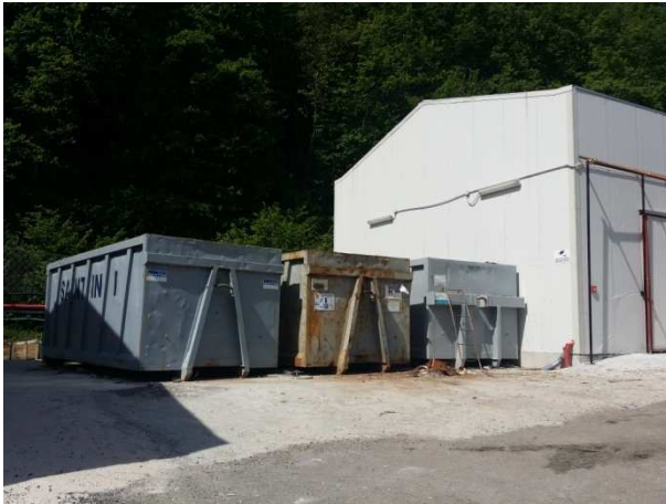
Baustelle Unterplattner/Cantieri di Unterplattner
