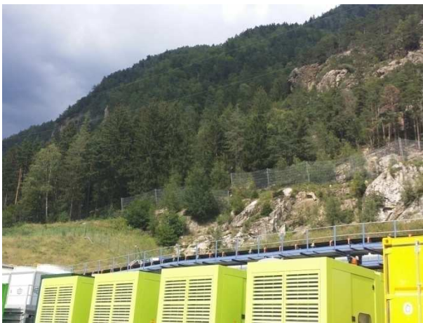
Steinschlagnetze auf dem Hang oberhalb des Baustellengeländes - Reti paramassi sul versante che sovrasta il cantiere
