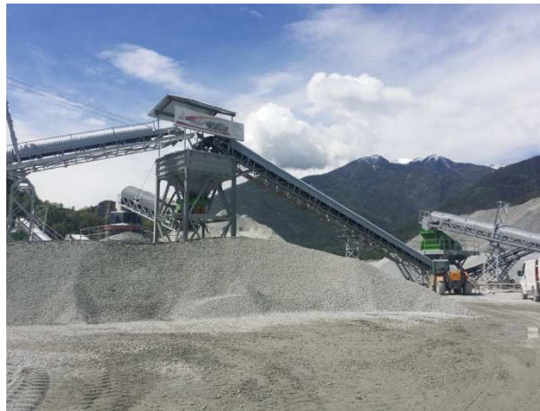
Brechanlage - Impianto di frantumazione
