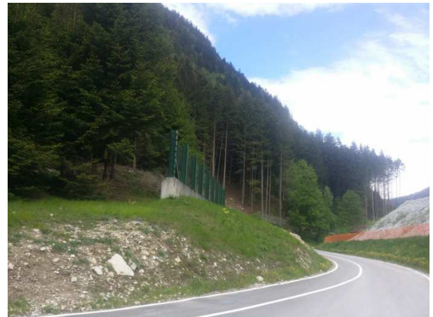
Steinschlagschutznetze oberhalb des Radweges - Reti paramassi a protezione della pista ciclabile
