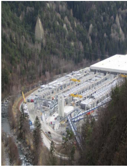
Aussicht auf Materialhaufen / Vista cumuli di materiale
