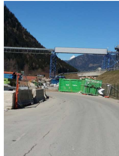
Baustelle Mauls 2 -Cantiere di Mules 2
