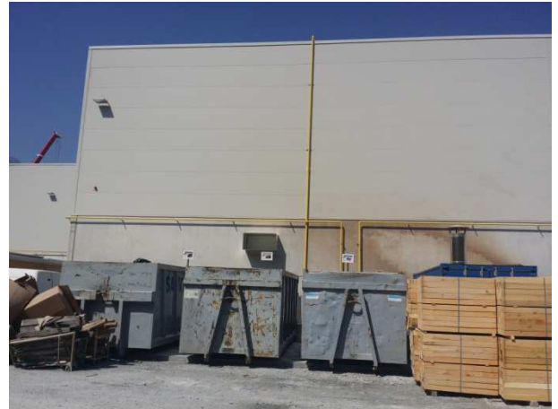
Baustelle Hinterrigger / Cantieri di Hinterrigger
