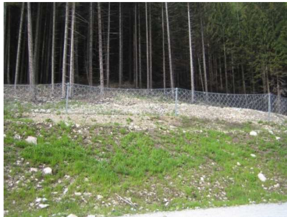
Böschung am Hangfuß - Scarpata alla base del versante
