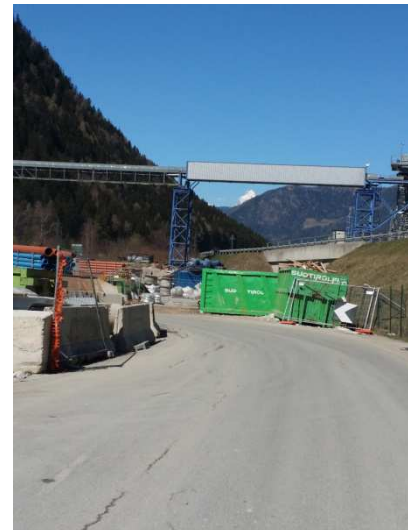
Baustelle Mault 2 - Cantiere Mules 2
