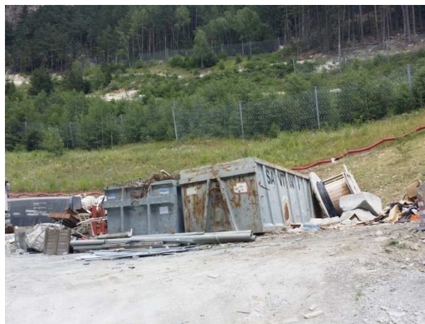
Begrünung entlang der Böschung Rinverdimento lungo il versante
