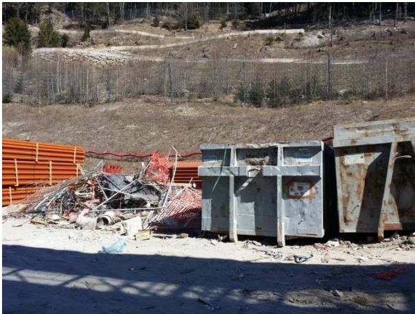
Baustelle Mauls1 -Cantiere di Mules1
