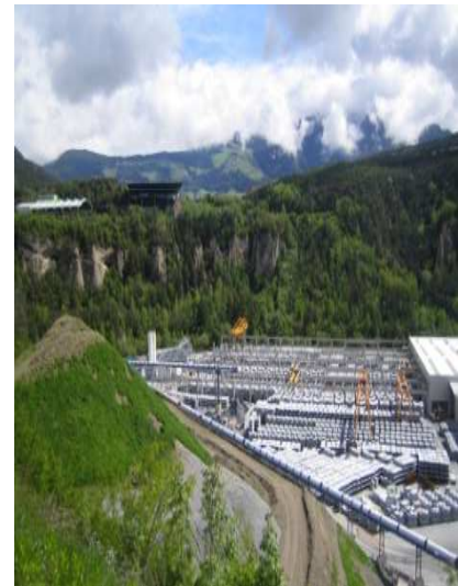
Baustellenanlagen / Infrastrutture Impiantistiche
