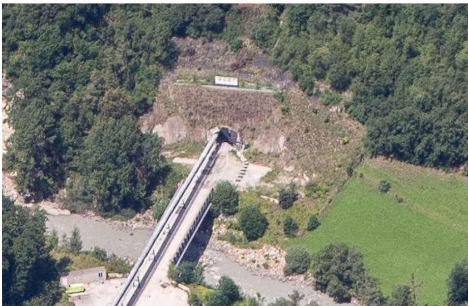
Figura 3: visione d'insieme del portale di Aica; è possibile notare che su ampie superfici delle scarpate laterali appare il rivestimento in calcestruzzo proiettato che doveva essere ricoperto da inerbimento e la parete centrale con vegetazione stentata o seccata
