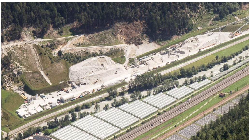
Figura 1: vista d'insieme del cantiere di Mules a settembre 2014; è possibile notare le problematiche principali: le opere in muratura del portale, le scarpate detritiche della strada di servizio, il versante privo di vegetazione arbustiva e arborea, i rilevati che circondano il cantiere di forma rigidamente geometrica (foto fornita da BBT)
