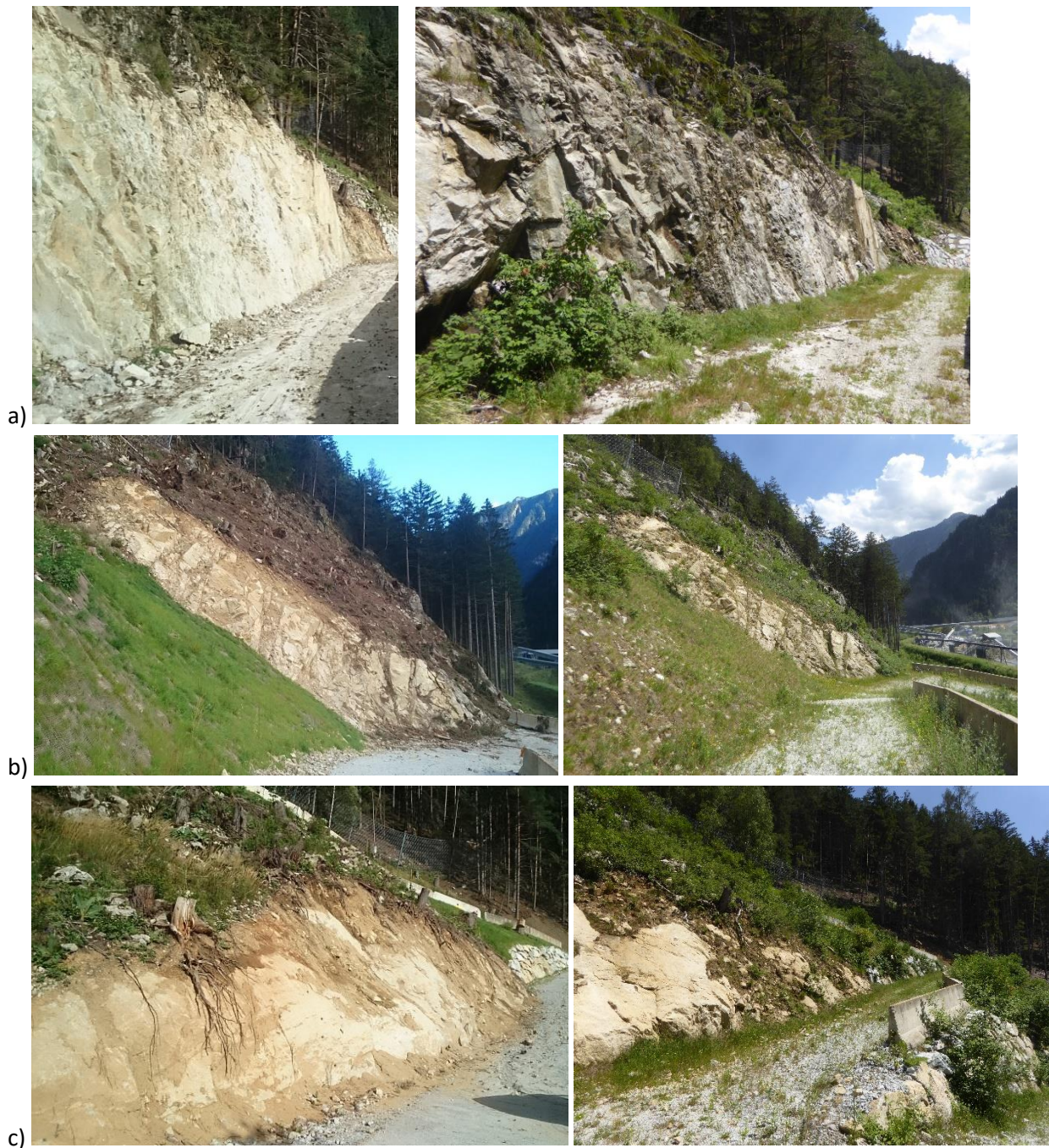
Figura 12: scarpate in roccia, a sinistra prima dell'utilizzo, a destra luglio 2019. a) parte sommitale della strada in cui l'azione principale è stata esercitata dall'invecchiante, ma con presenza di "patches" vegetate, b) e c) lungo la strada con effetto più meno marcato dell'inerbimento.
