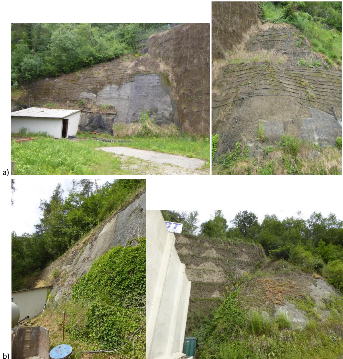
Figura 15: parete laterale del portale di Aica, a) prima dell'intervento, b) a luglio 2019
