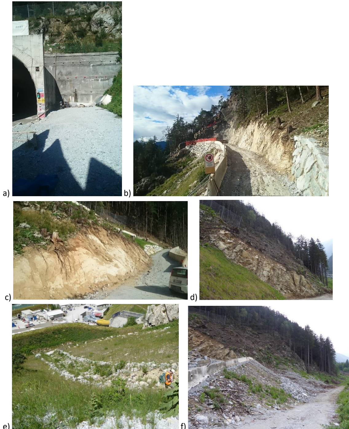
Figura 2: situazione precedente gli interventi: a) portale, b) c) e) scarpate in varie parti della strada verso il pozzo d'areazione, e) versante e canale a lato del portale, f) scarpata di valle all'attacco della strada
