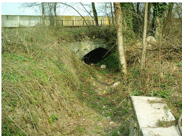
Questo manufatto esistente viene rifatto, in quanto la rampa e l'opera del cavalcavia vengono riprogettate nell'ambito del rifacimento della linea A.C. La sua dimensione viene adeguata a quella del tombino di monte, riportato qui di seguito; viene quindi previsto come scatolare.
