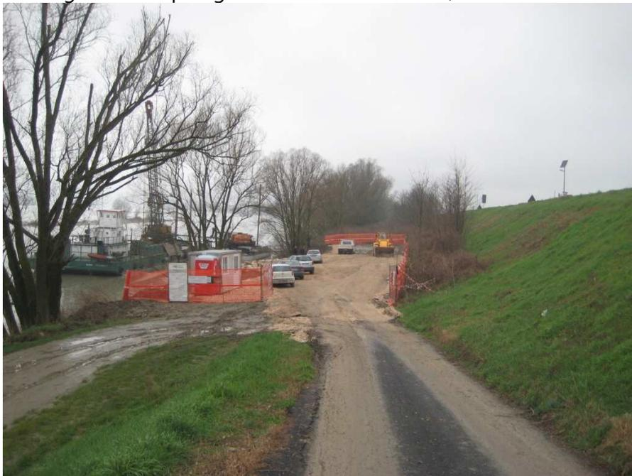
Figura 2 – Esempio di area logistica principale (baraccamento tra argine maestro e alveo inciso)
