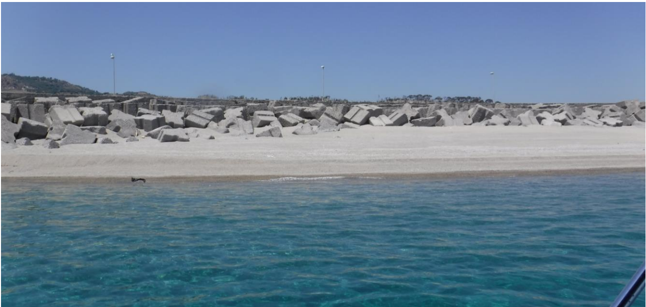
Figura 12.7 Zona di accumulo molo di sopraflutto (lato mare)
