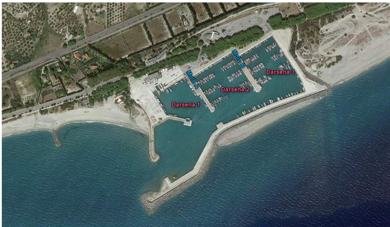
Figura 4.1 Foto satellitare del sito di intervento
