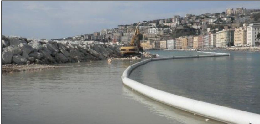
Figura 5-3 – Utilizzo di barriere anti-torbidità durante i lavori
