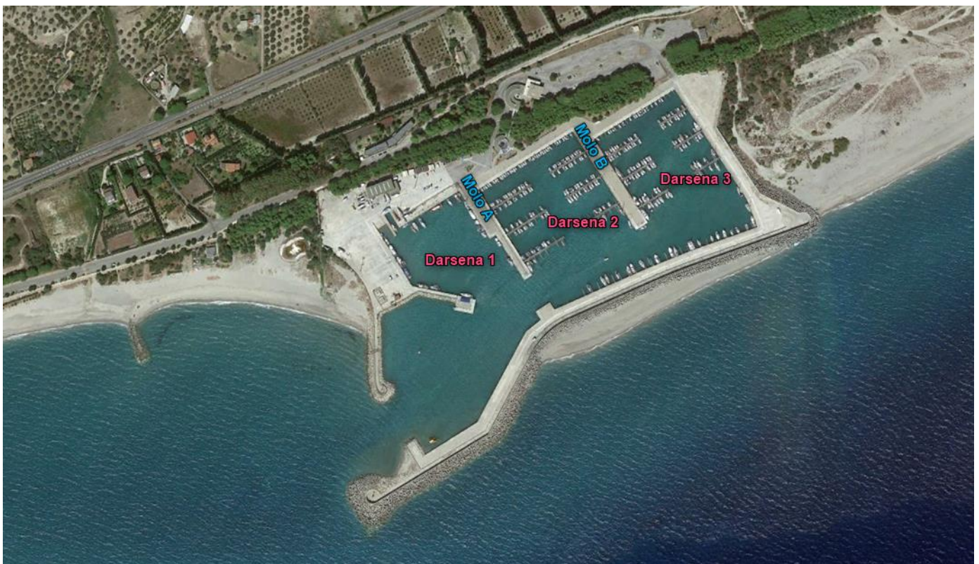
Figura 3.4 Foto satellitare del sito di intervento
