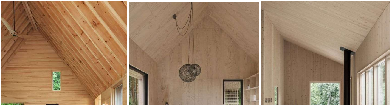
Figura 2.3 Intradosso del tetto in legno
