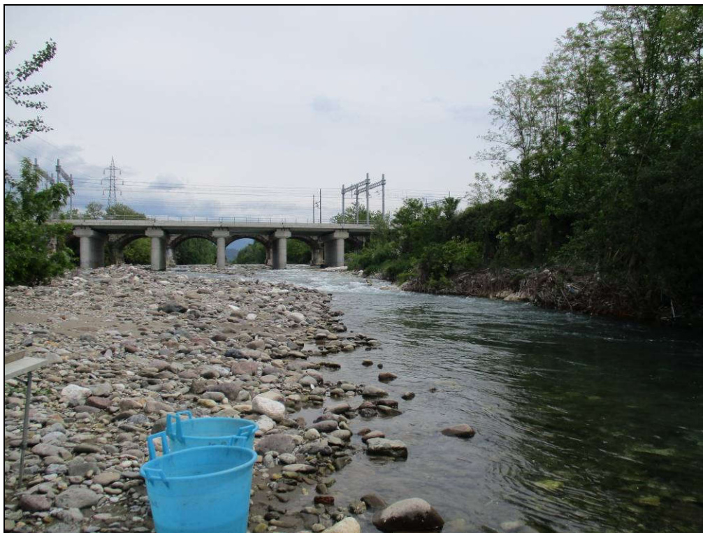
Foto 1.1 – Fiume Mella a valle del nuovo ponte della LINEA AV/AC, maggio 2019
