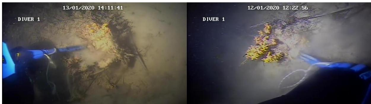
**Figura 6.16 L'uso di martello e scalpello per rimuovere selettivamente nuclei di bioconcrezionamenti**
