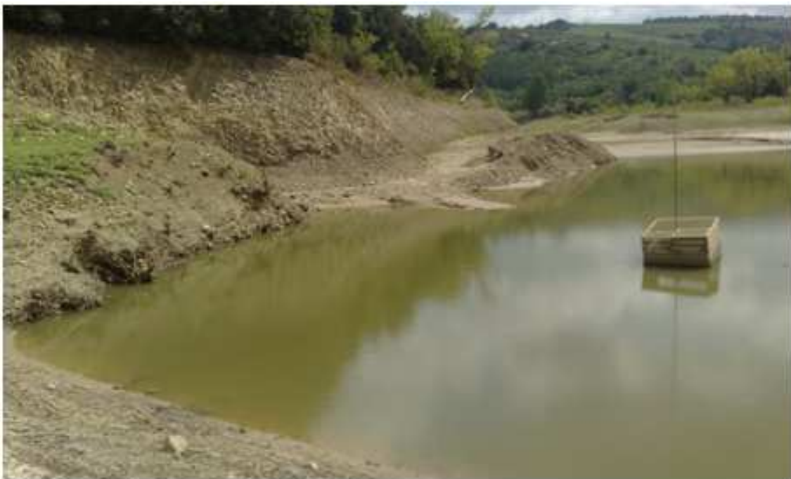
Figura 39 – Opera di presa
