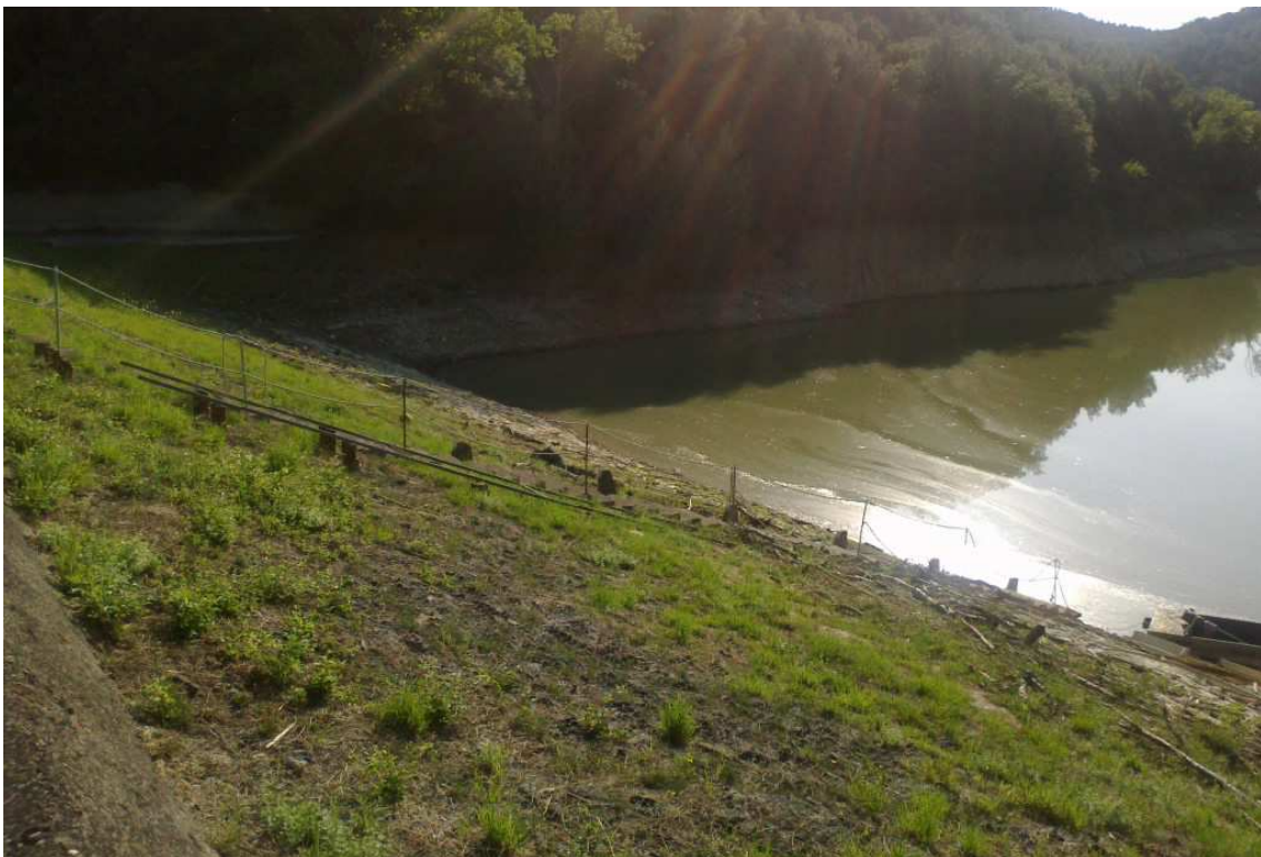
Figura 34 – Paramento di monte.
