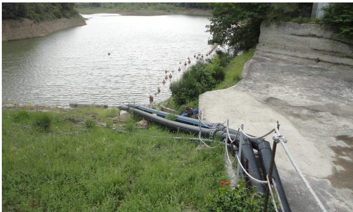
Figura 40 – Punto di presa degli scaricatori a sifone
