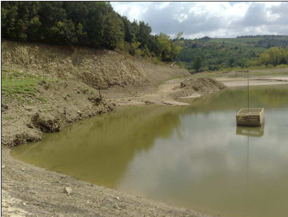
Figura 3-8 – Opera di presa esistente (estate 2003).
