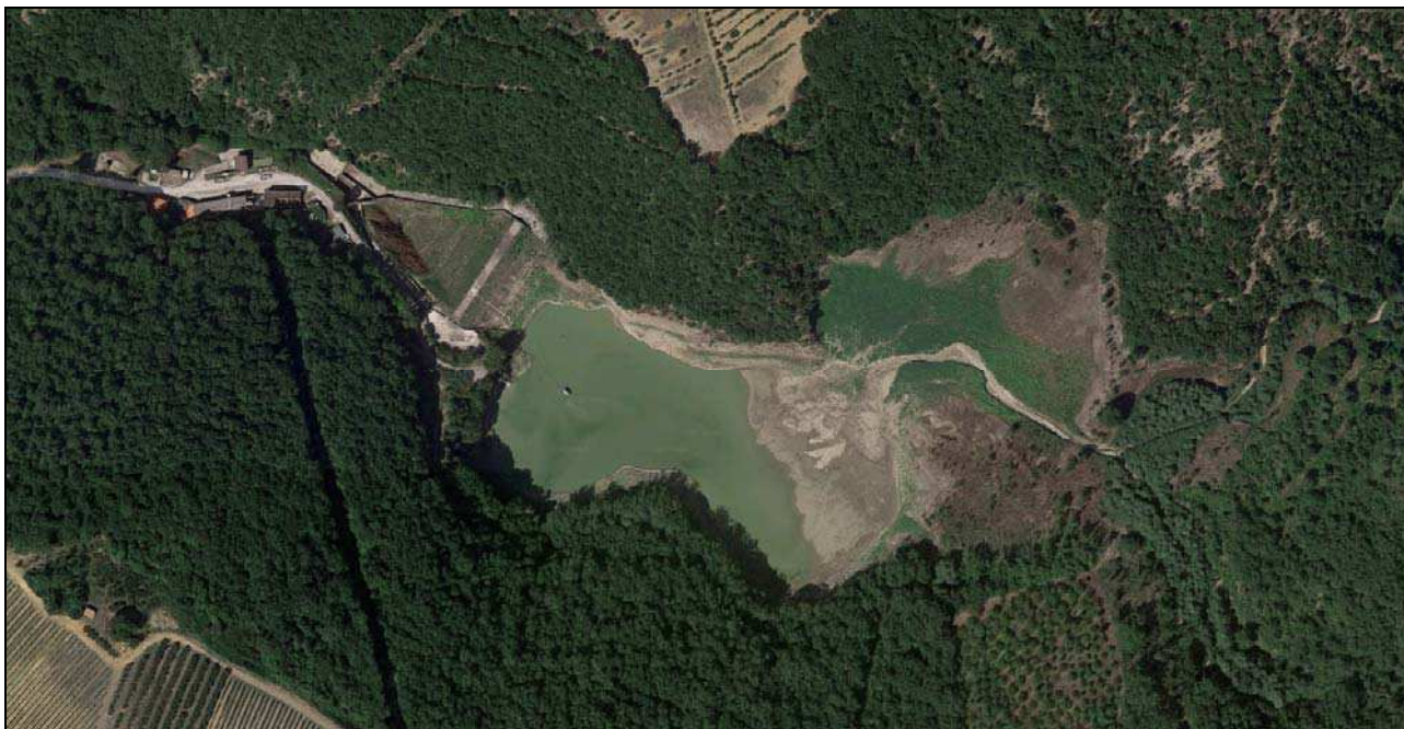
Figura 3-5 – Vista aerea della diga di Cepparello con limitazione di invaso alla quota di 177.0 m s.l.m..
