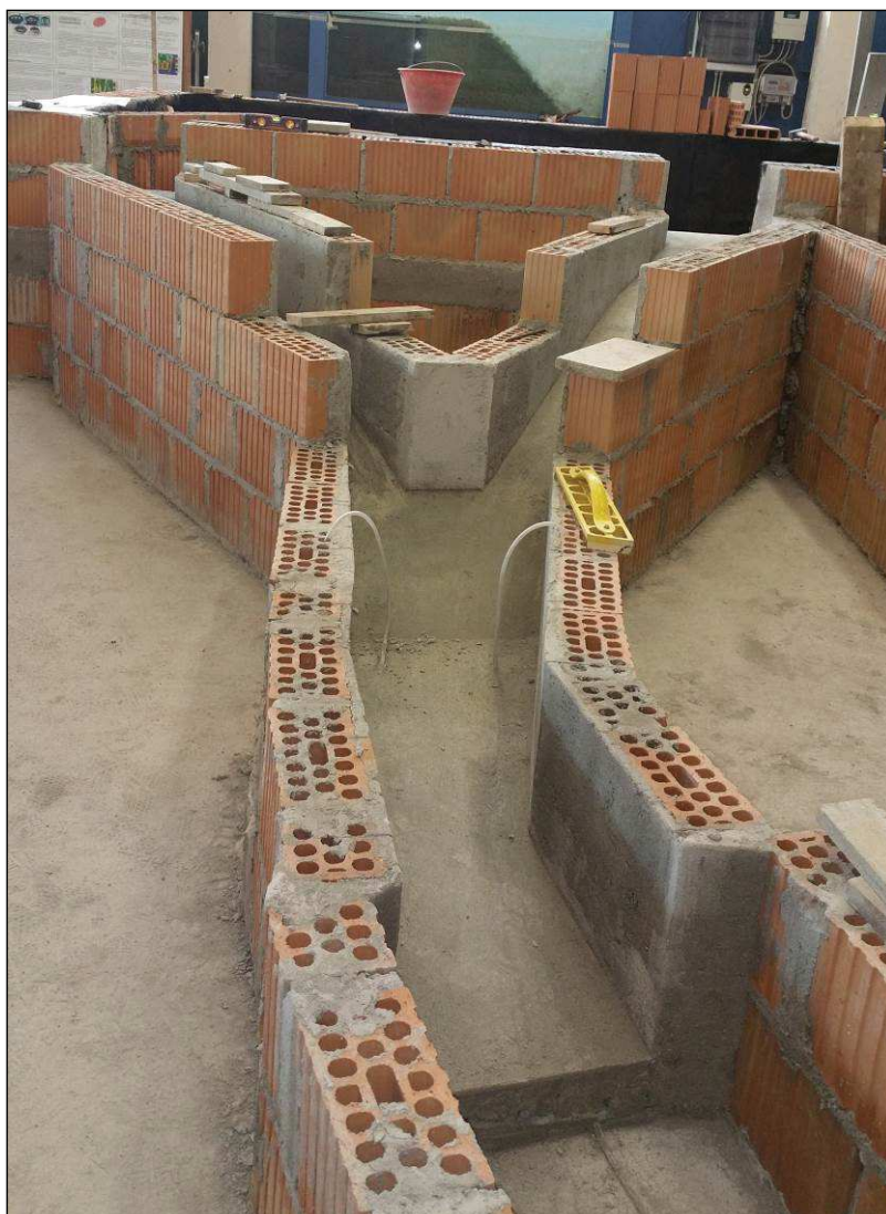
Foto 2 Vista da valle del modello in avanzata fase di costruzione (settembre 2018).
