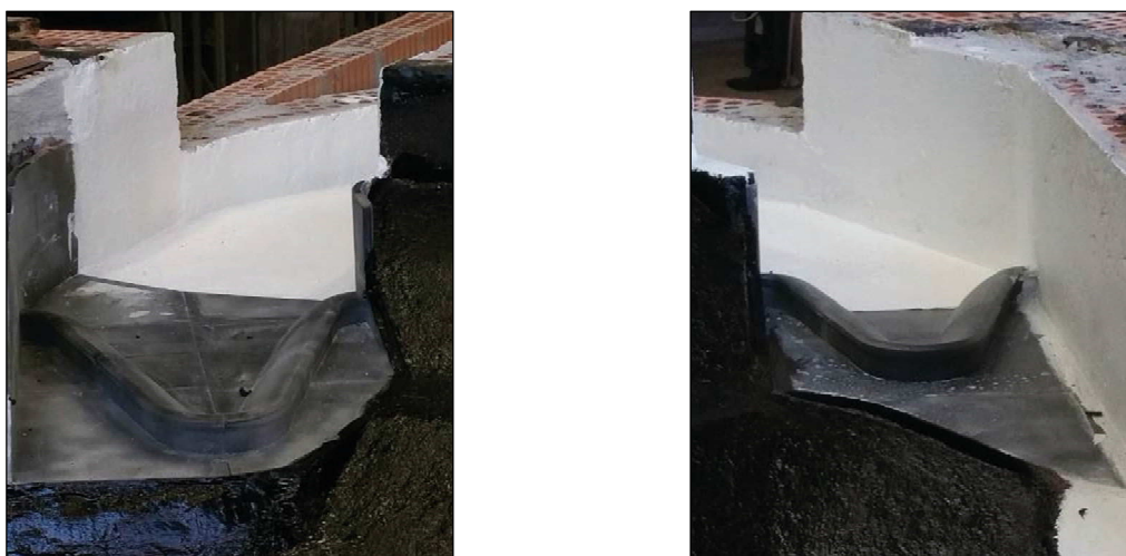
Foto 4 Vista di dettaglio degli sfioratori a becco d'anatra in sinistra e in destra.
