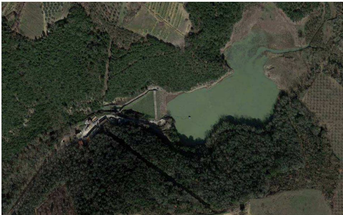
Figura 2-2 - Diga Drove di Cepparello. Fonte Google Maps
