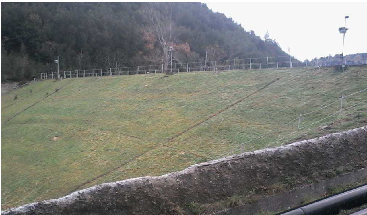
Figura 2-4 – Impianto di illuminazione sul coronamento
