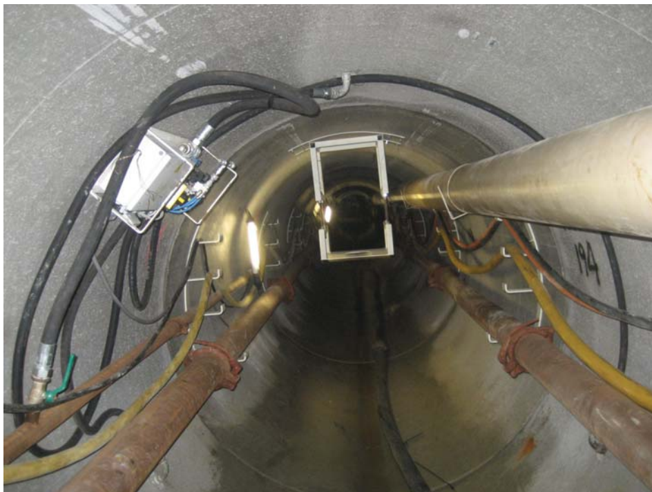
Figura 4.2 – Cavi elettrici, tubazioni per l'impianto di smarino e idrauliche messe in opera all'interno della condotta in fase di avanzamento.
