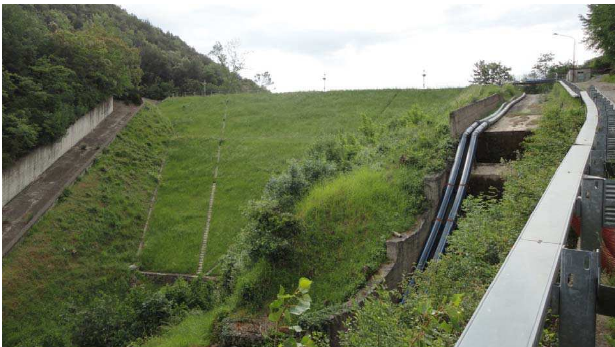
Figura 13 – Passaggio degli scaricatori sullo sfioratore di sinistra
