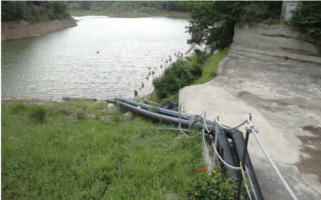
Figura 12 – Punto di presa degli scaricatori a sifone
