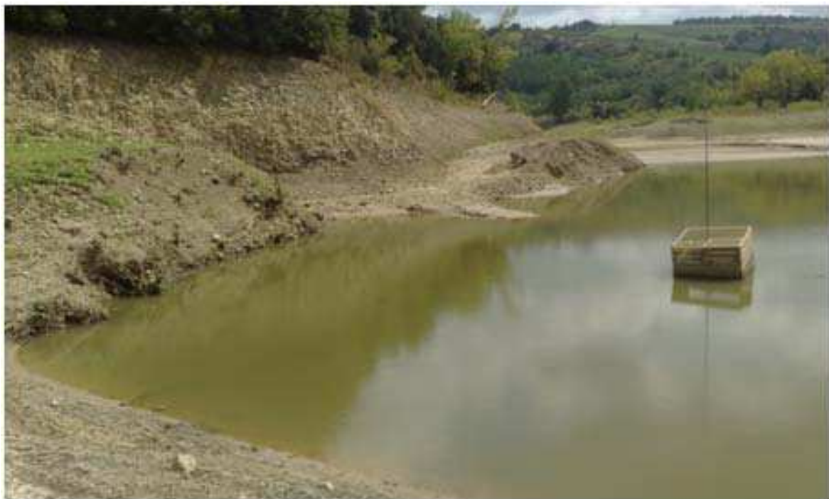
Figura 7 – Opera di presa
