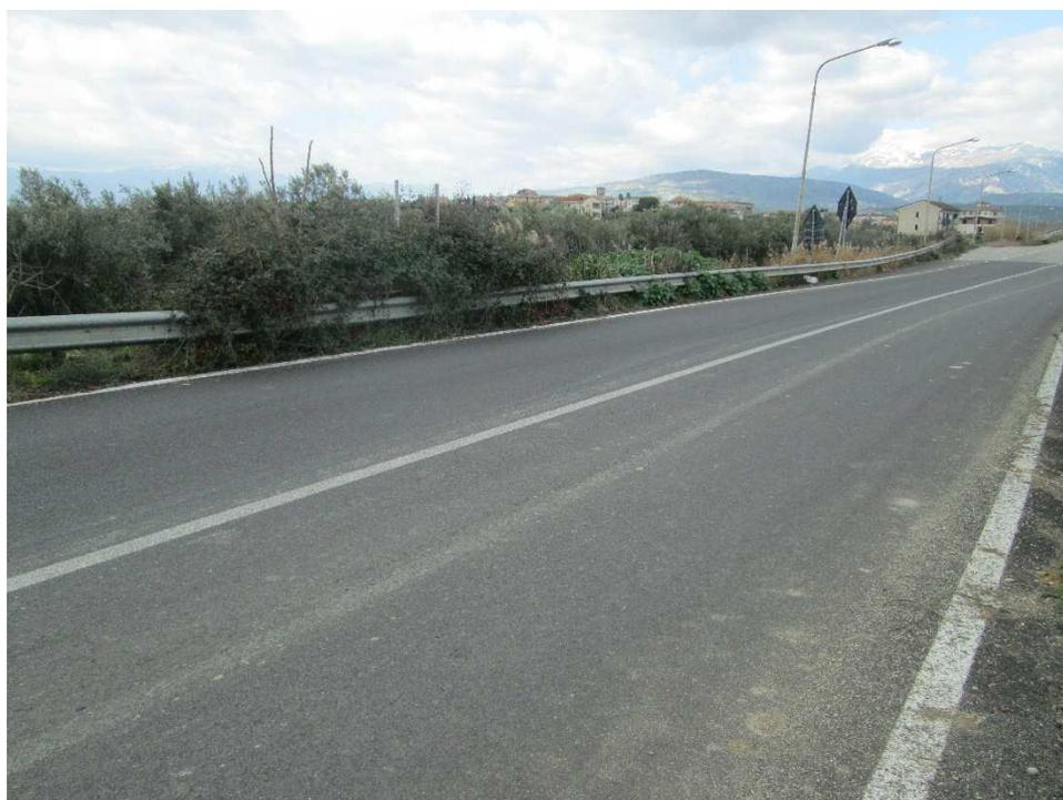
**Vista 2** - Particolare dello stato d'usura del manto stradale provvisorio sulla SP166, nel quale si osserva il completo ripristino.
