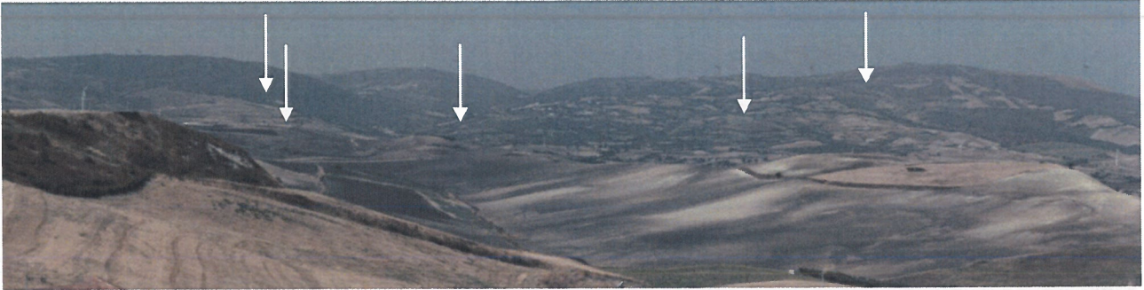
PANORAMICA DELL'IMPIANTO DA TROIA (distante 1400 m) - ANTE OPERA
