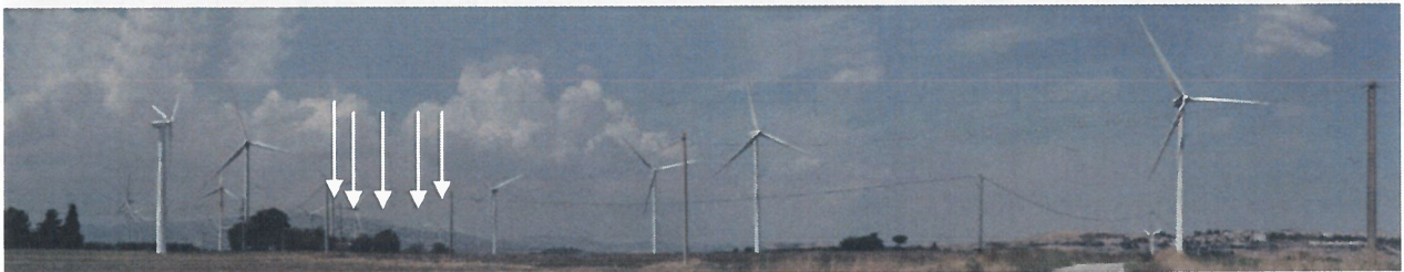
PANORAMICA DELL'IMPIANTO DA MASSERIA SAN FRANCESCO (distante 4500 m) - POST OPERA
