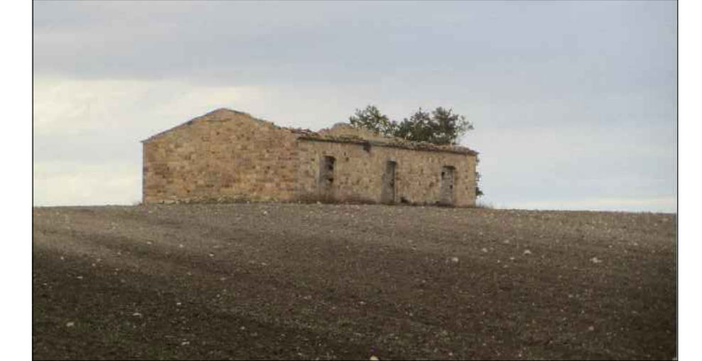
FOTO EDIFICIO F.19 P.lla 22 Col. F/2-unità colabent
