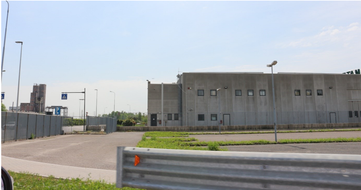
Figura 4.7.5 - Impianti industriali a Fusina
